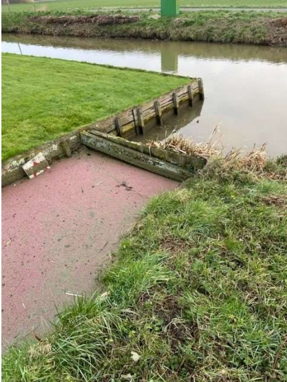
Afbeelding 8: Vaste dam KVD-566
