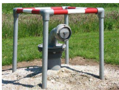
Figuur 2: vaste bovengrondse aansluiting gesloten geboorde put.
