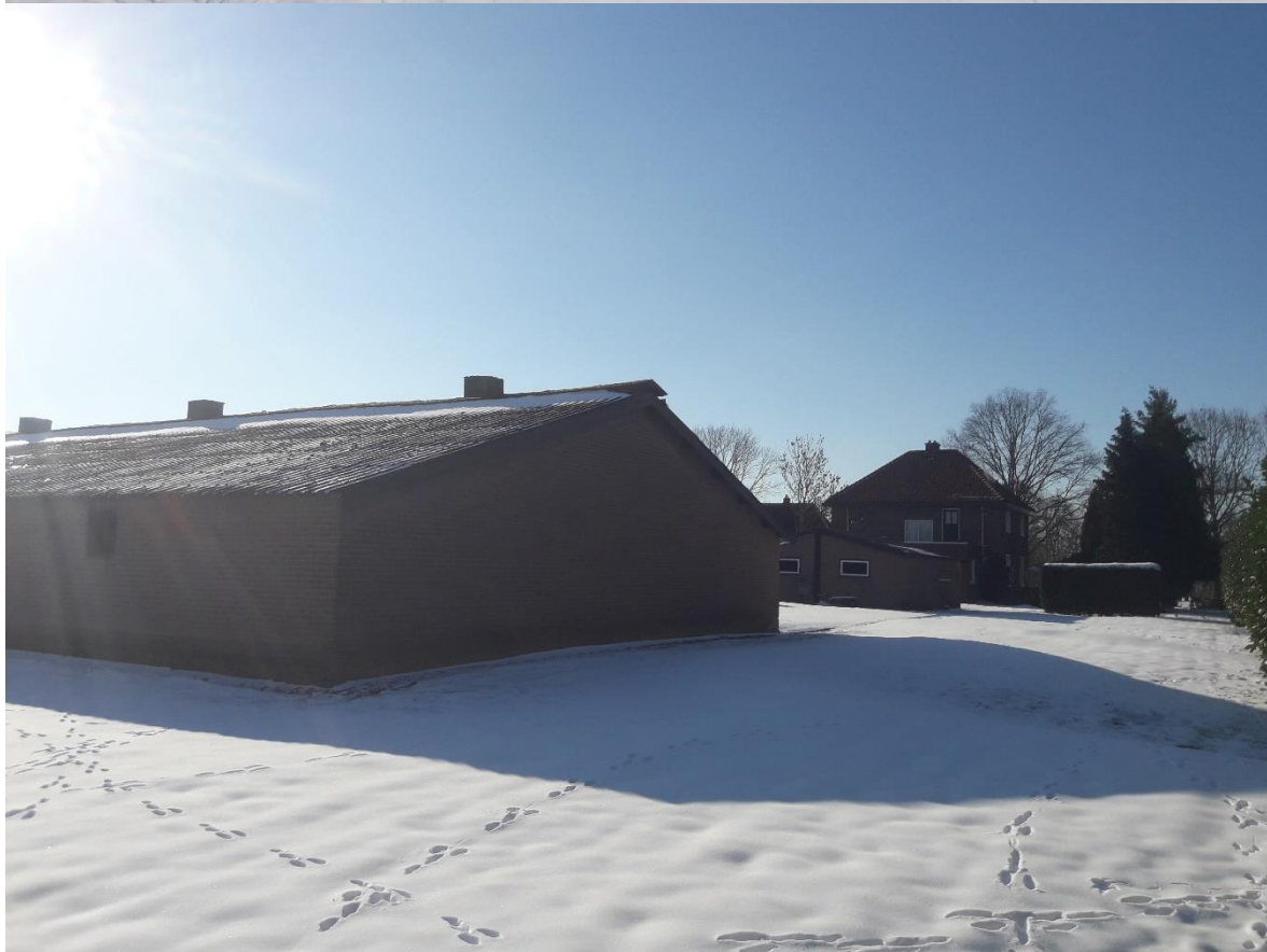
Foto's huidige situatie stal (d.d. 12 februari 2020)
