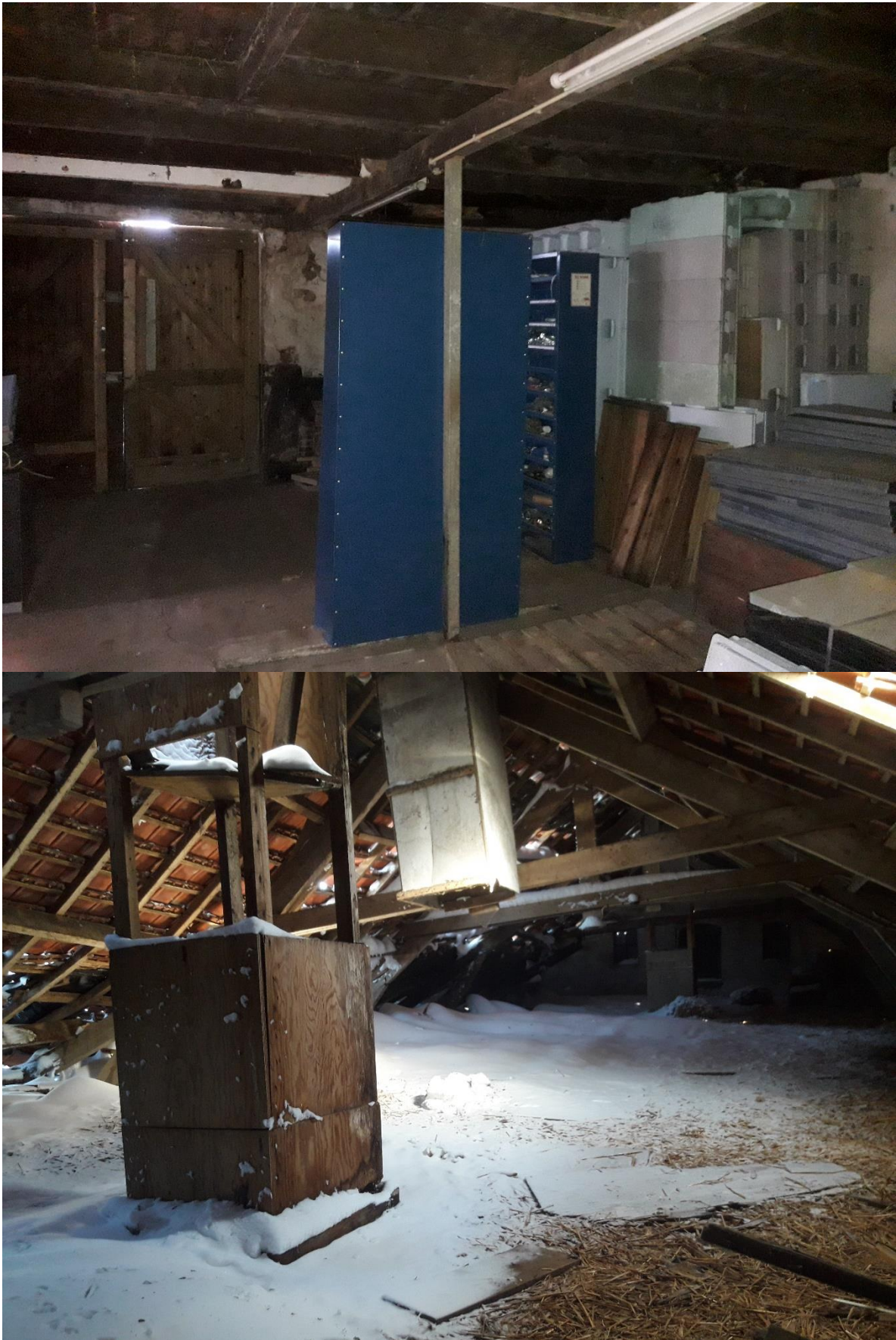
Foto's huidige situatie beneden- en bovenverdieping schuur (d.d. 12 februari 2020)
