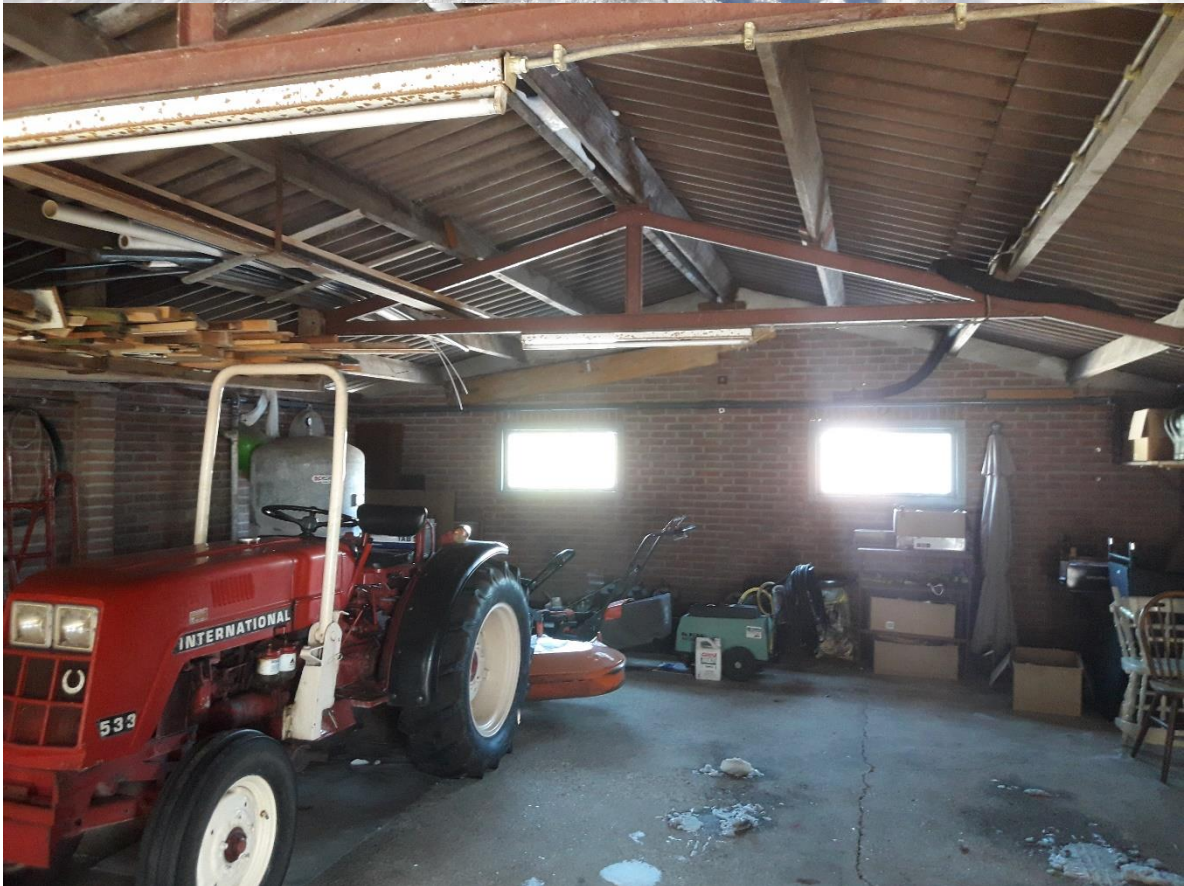
Foto's huidige situatie garage (d.d. 12 februari 2020)
