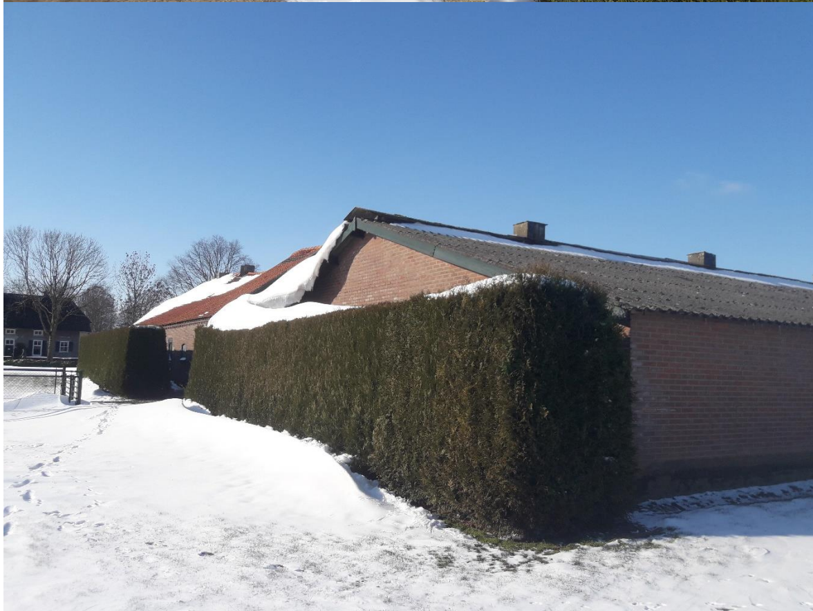
Foto's huidige situatie stal (d.d. 12 februari 2020)
