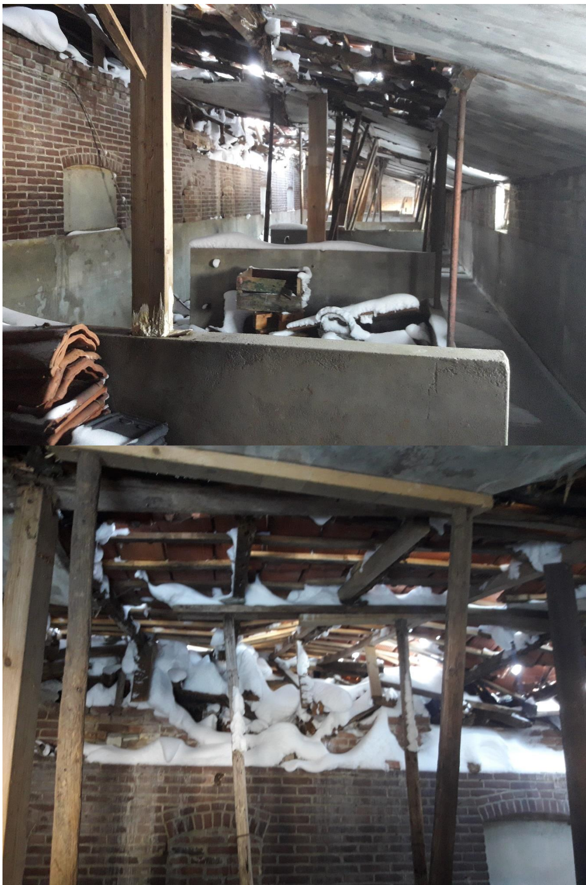
Foto's huidige situatie noordelijke aanbouw van de schuur (d.d. 12 februari 2020)
