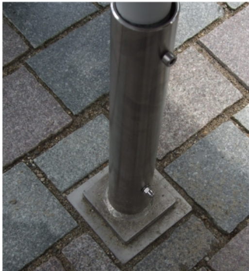
2 voorbeelden bevestiging parasol in pleinvloer
