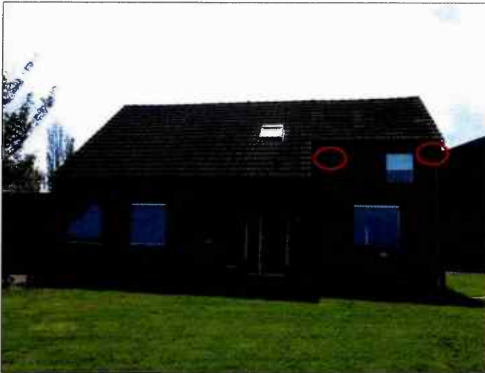
Voorgevel van de woning waaraan twee van de vier huismuskasten worden geplaatst. Met de rode cirkels wordt de locatie van de twee kasten aangeduid.
