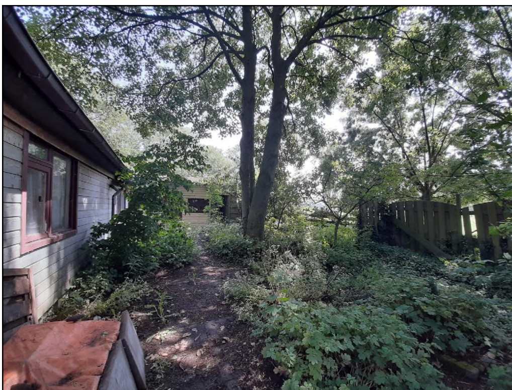
Figuur 2 De zuidelijke zijde van de woning met een stuk van de tuin.
