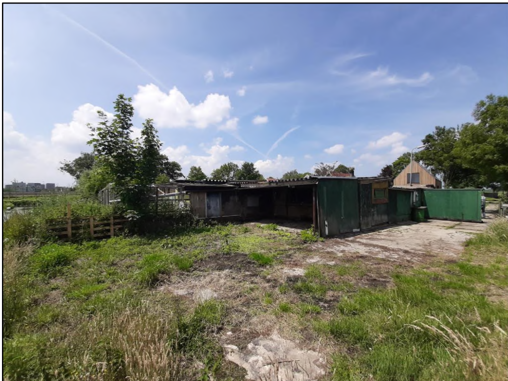
Figuur 4 De schuur gezien vanuit het zuiden/zuidoosten.
