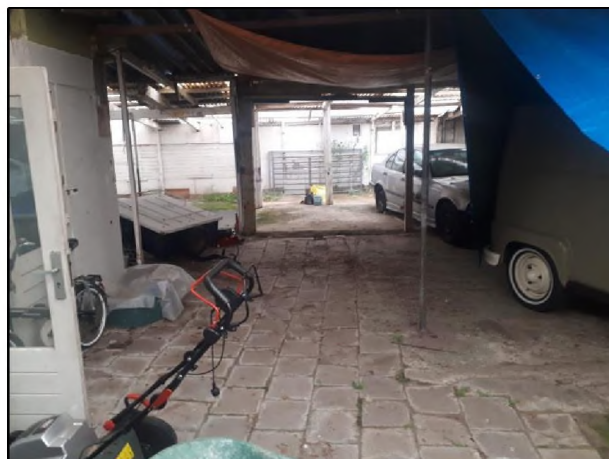
Foto 8: Schuren, binnenzijde, gezien in zuidelijke richting
