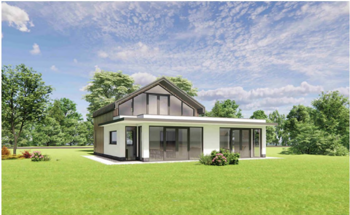
Fig. 3.5 Achtergevel nieuwe woning
