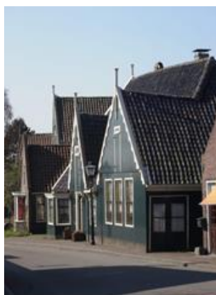
Het kleur- en materiaalgebruik dient volgens traditioneel gebruik te zijn
