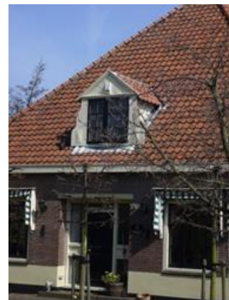
Het kleur- en materiaalgebruik dient volgens traditioneel gebruik te zijn
