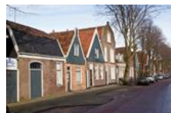
De afwisseling in goot en/of nokhoogte moet gehandhaafd worden
