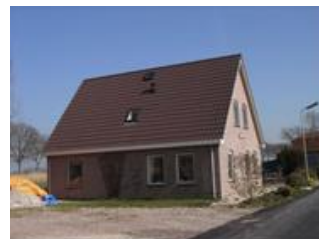
Een pand waarbij niet genoeg aandacht is besteed aan de plaatsing van de entree
