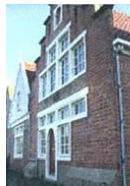
De straatwanden worden gevormd door gevels met wisselende raamindelingen
