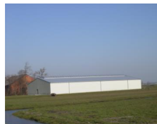
Een situatie waarbij het materiaal en de kleur niet voldoen aan de gebiedsspecifieke eigenschappen
