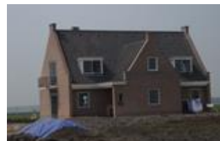
Aanbouw niet voldoende ondergeschikt aan het hoofdgebouw
