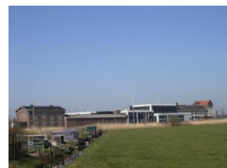
De horizontale aaneenschakeling van hoofd- en bijgebouwen is niet in lijn met de karakteristieke verkaveling van het landelijk gebied
