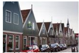
De afwisseling in nokhoogte moet gehandhaafd worden
