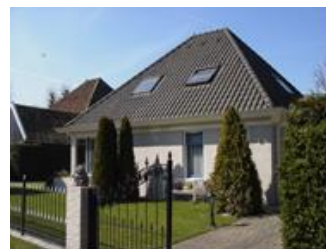
Witte steen als hoofddrager is niet toegestaan
