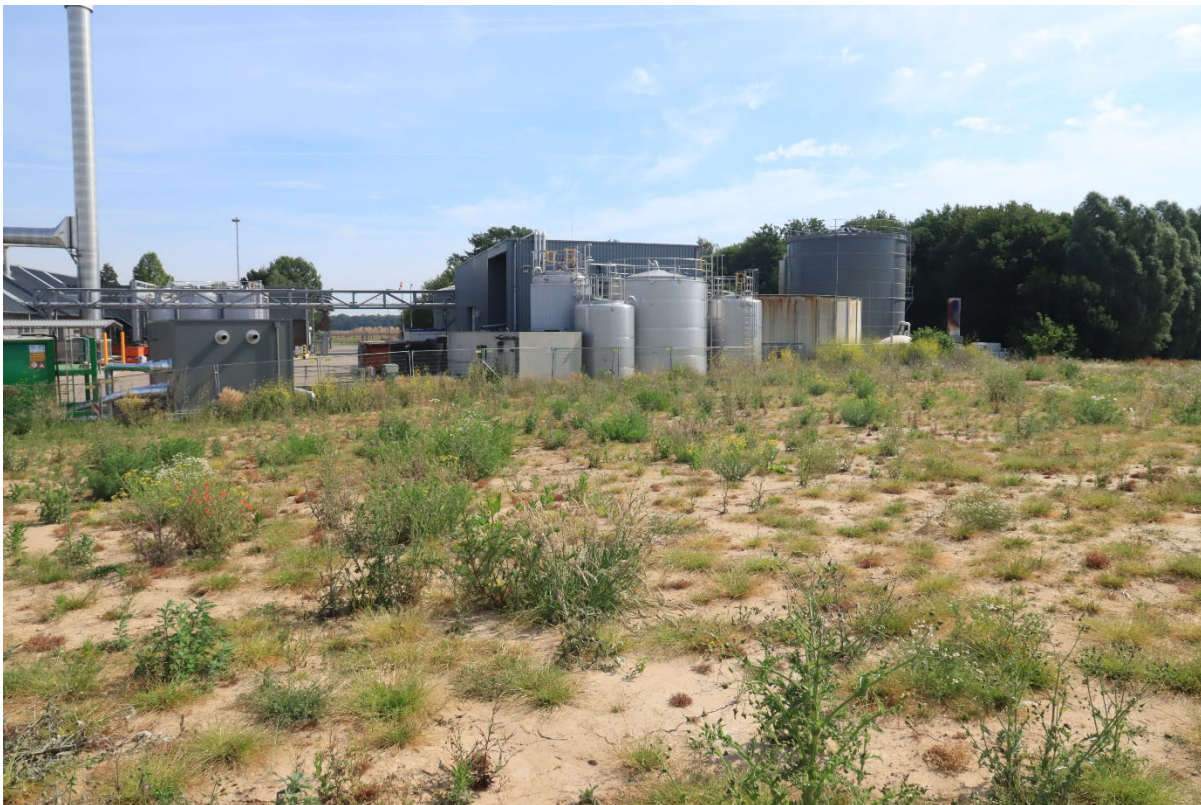
Figuur 3-6: Locatie uitbreidingsperceel voor o.a. nieuwe sprinklertank.
