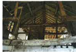
De wand tussen schuur en woonhuis. Het bovenste deel van de spantconstructie is in de negentiende eeuw vervangen door een A-spant.
