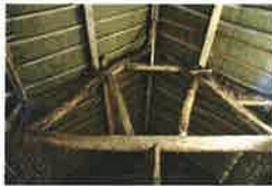
In het achterste spant is voor een deel nog de vakwerkruifing te zien, daterende uit de periode dat dit de achterzijde achtergevel van de schuur was (v. 1850).
