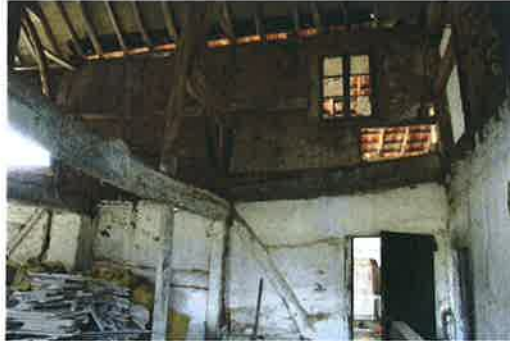
De zuidgevel van de schuur bestaat voor het grootste deel nog uit vakwerk met vlechtwerk en leempleister
