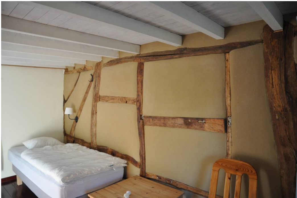
De interne vakwerkconstructie van de zuidelijke vleugel
