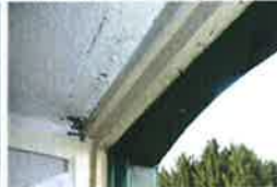
In de gestoogde bovendorpel zijn nog sporen van traliewerk aanwezig
