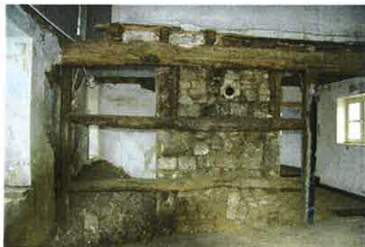
De meest wettelijke oude stoekplaats, gezien vanaf de (geen)trijde achterzijde. Aan de achterzijde is eveneens een vakwerkwand aanwezig.
