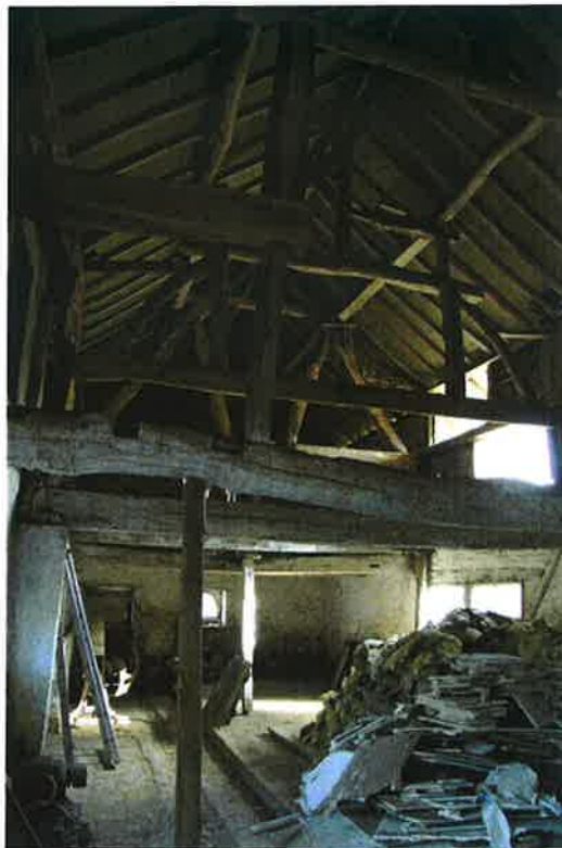
De schuur waarvan de oorspronkelijke vakwerkconstructie nagenoeg geheel bewaard is gebleven
