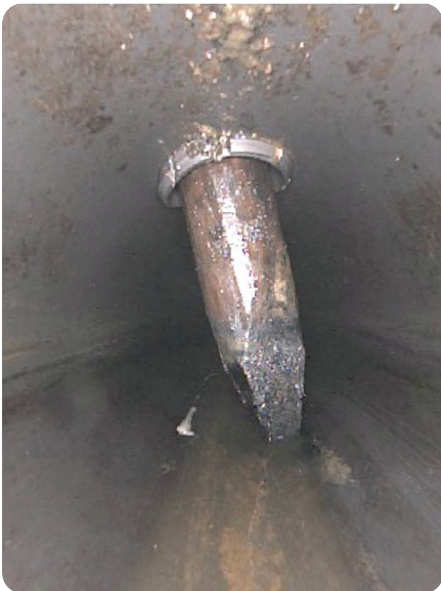
Foto: beeld van een videoinspectie in Reeuwijk-Brug West, deze houten paal is verwijderd en de rioolinlaat is hersteld
