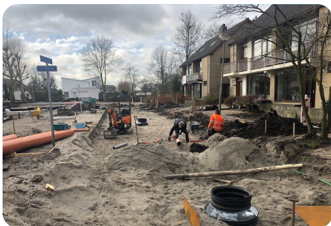
Foto: de reconstructie van Reeuwijk-Brug oost is in volle gang
