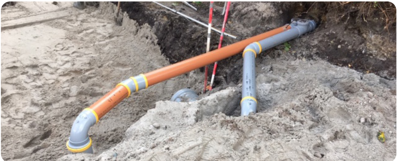
Foto: niet één afvoerleidingen per woning maar twee. Een voor het huishoudelijk afvalwater en de andere voor het hemelwater
