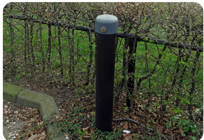
Foto: peilbuis aan de Pr Hendrikstraat
