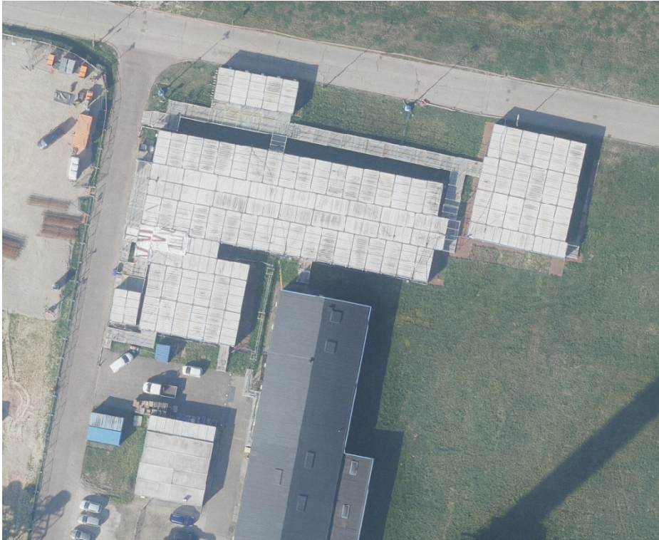
Luchtfoto van het bestaande ketenpark in 2022”
