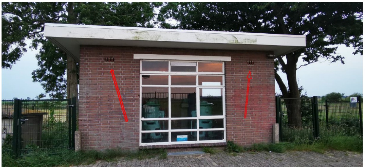
Figuur 2: De locatie van de paarverblijfplaatsen van ruige dwergvleermuis (rode pijl). De verblijfplaatsen bevinden zich in de spouw die toegankelijk is via het ventilatierooster.
