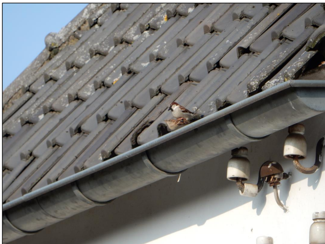
Figuur 3.2 Copulerende huismussen op de dakgoot van bijgebouw 2.
