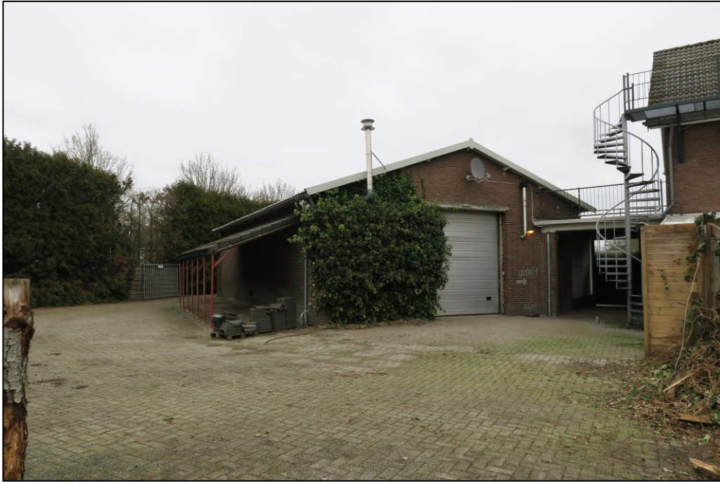
Figuur 1 Bijgebouw 1 op de planlocatie zal gesaneerd worden. Het bijgebouw is doormiddel van een overkapping verbonden aan de woning (rechts). De woning blijft behouden.
