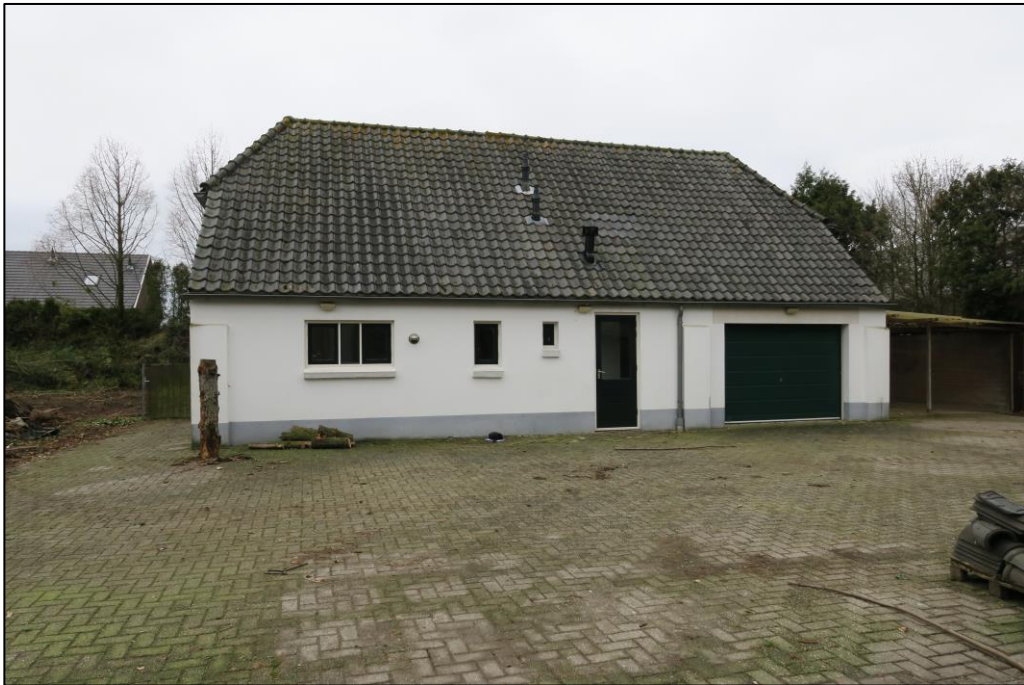
Figuur 2 Bijgebouw 2 op de planlocatie zal gesaneerd worden.
