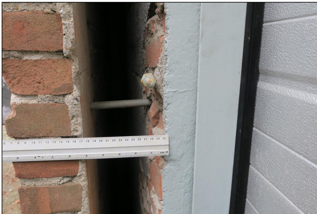
Figuur 4 De luchtspouw is zeer groot (circa 11 cm) en open toegankelijk, waardoor deze ongeschikt is voor vleermuizen.
