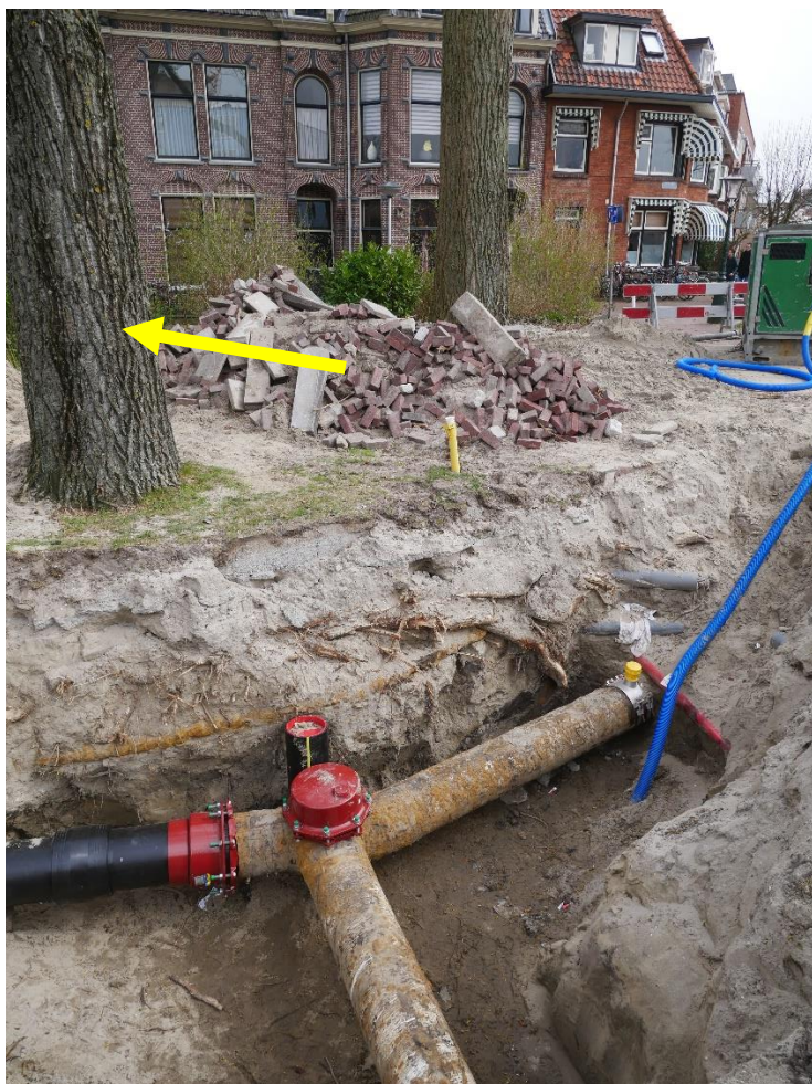
Foto 4: Vernieuwde leiding bij boomnummer 6.
