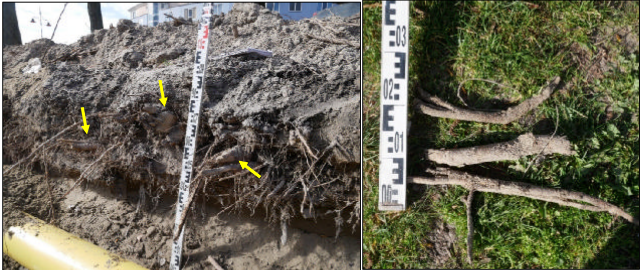
Foto 8 en 9: Links een beeld van de beschadigde wortels van boomnummer 3. Beschadigde stabiliteitswortels met een \varnothing > 5 cm zijn met gele pijlen aangeduid. Rechts wortelrestanten aangetroffen bij de stamvoet van boomnummer 4.
