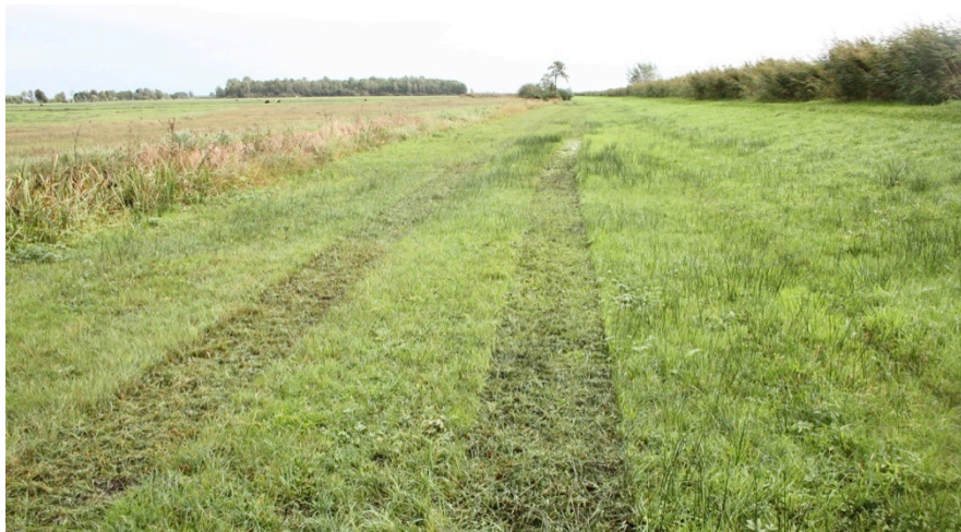
Figuur 5 Insporing en waterstagnatie op de vlakke dijkteen, met rechts het riet langs de boezem. Paddenrus groeit hier tot halverwege het talud.
