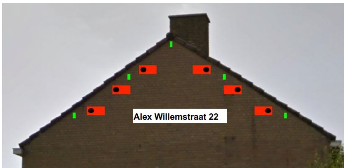
Figuur 2: Locaties permanente voorzieningen. In rood de inmetsele kasten voor de gierzwaluw en in groen de open stootvoegen voor vleermuizen (Cardinaals, J.T.B., Koopman-Van Roon, A.D.G., 2022).
