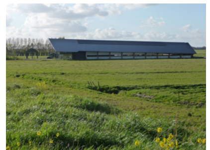
Voorbeelden: nieuwe stal met architectonische kwaliteit in Zwartsluis
