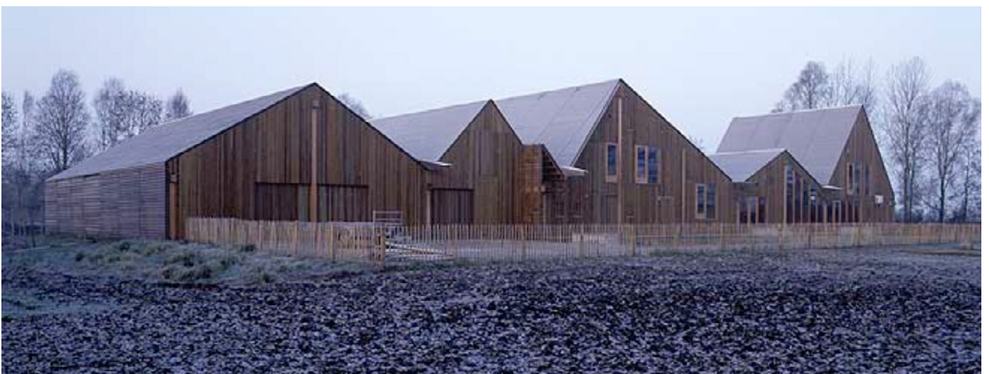
Beeld werkerven aan de es: Kans voor nieuwe werkmilieus die voortbouwen op de karakteristieken van de vrijkomende Twentse erven. [Referentie ONIX architecten]
