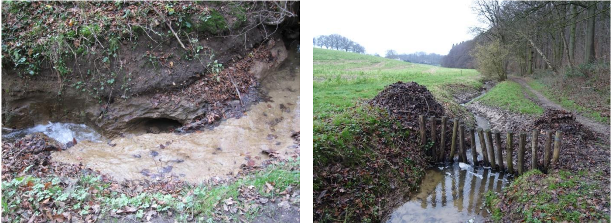
Figuur 1 Links: Insnijding Strabekervloedgraaf. Rechts: Remmende maatregelen zoals paaltjes verminderen de stroomsnelheid, leiden tot sedimentatie van organische materialen en zijn aan onderhoud onderhevig waardoor de macrofaunalevensgemeenschap wordt verstoord.
