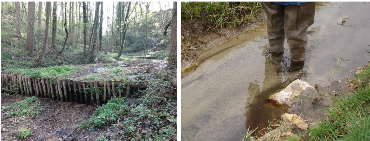
Figuur 4 Links: Terrasvorming als maatregel in de bronbeek Hussebeek. Rechts: Lemige sedimenten worden afgezet in dikke lagen en bedekken de voor bronbeekorganismen benodigde stenen en grindbanken.
