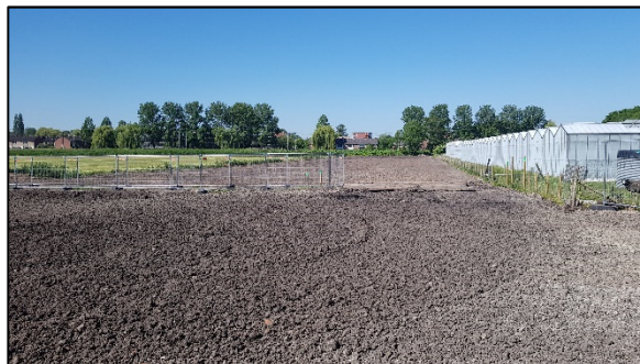
Afbeelding 2: terrein van de gesloopte kas aan de Nieuwkoopseweg 5C op 14 juni 2021.
