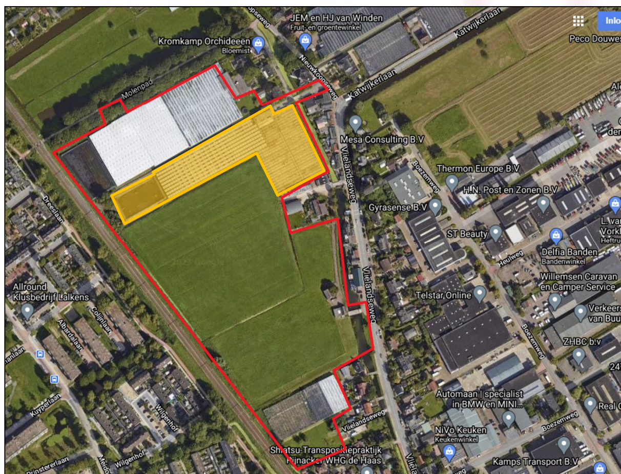
Afbeelding 1: projectbegrenzing weergegeven met een rode lijn. De met oranje gemarkeerde kas en bassin zijn reeds gesloopt. Daarnaast is in een deel van het gebied reeds voorbelasting aangebracht.
