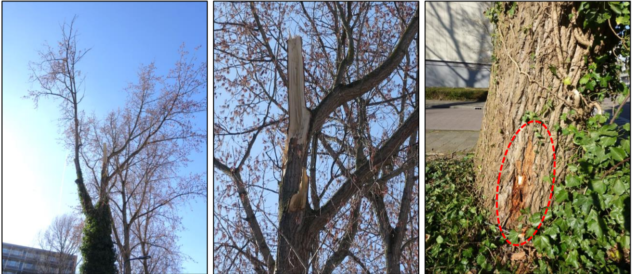
Fig. 3: Boom nr. 4 is een populier met een matige conditie waarbij recentelijk een zware top uit de kroon is gebroken. Daardoor is de rest van de kroon instabiel geworden. Aan de zuidzijde van de stambasis is houtrot aangetroffen (rechts) die mogelijk wordt veroorzaakt door de Honingzwam. Ook daardoor is de levensverwachting afgenomen en wordt de boom in toenemende mate vatbaar voor windworp.
