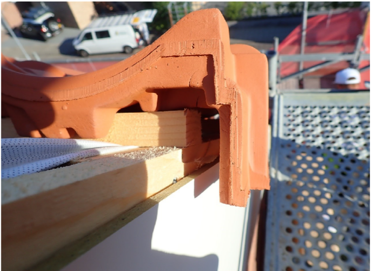
Figuur 10: Visualisatie overhangende kantpan met 3 centimeter ruimte.
