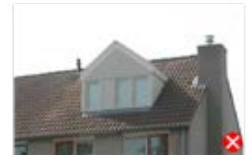
vormgeving sluit niet aan op stijl van woning
