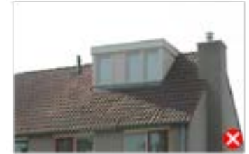
te hoog op het dak, profiel van de woning wordt aangetast
