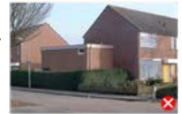
zijaanbouw te hoog
