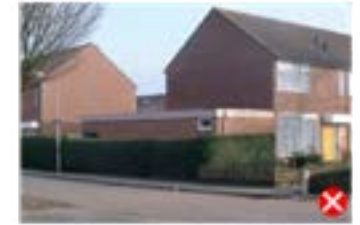
zijaanbouw te dicht bij voorgeveltoelijn
