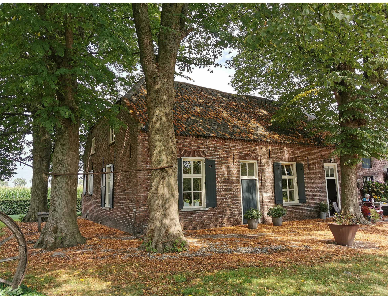
FOTO 1: WOONGEDEELTE ZUID- EN WESTGEVEL
