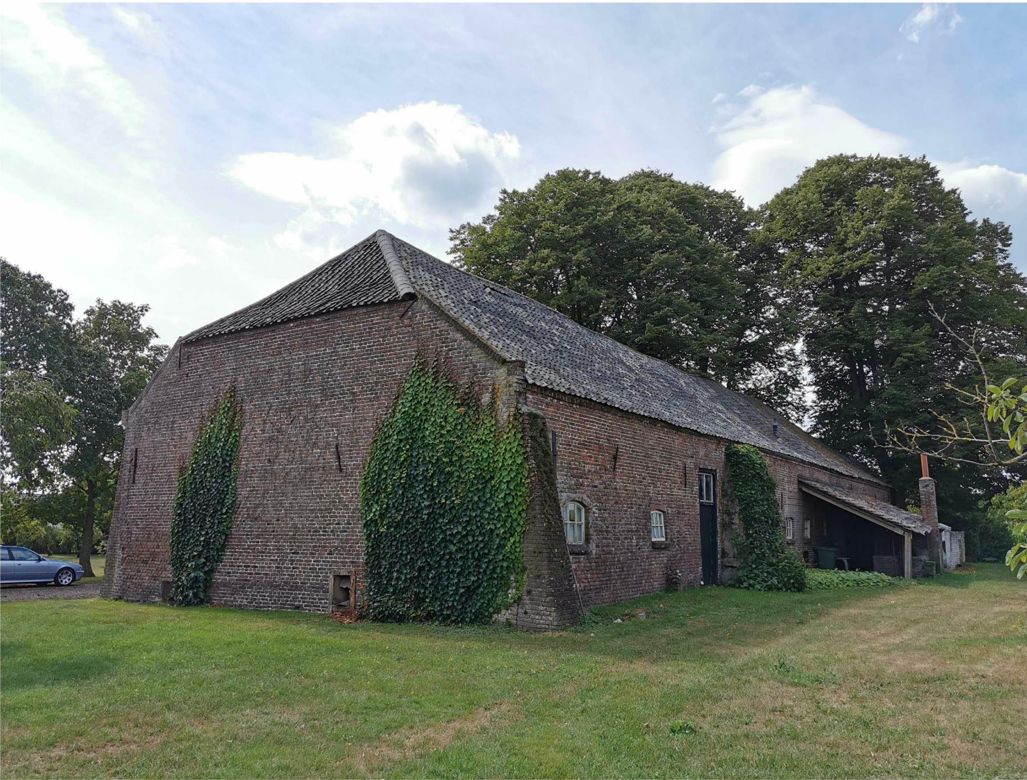
FOTO 2: SCHUURGEDEELTE NOORD- EN OOSTGEVEL
