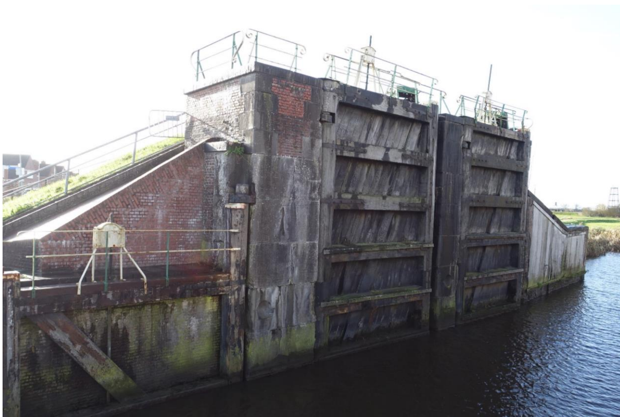
Figuur 87. Overzicht van de zuidelijke sluiswand. De noordwand heeft een grotendeels identieke, maar gespiegelde opzet.
