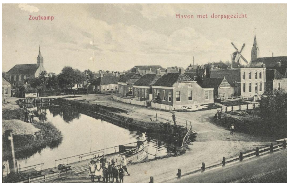
Figuur 37. Zicht vanaf de zeedijk, direct ten zuiden van de Hunsingosluis, op de tot binnenhaven omgevormde Oude Gracht omstreeks 1910. Bron: GA, nr. 1986_20437.
