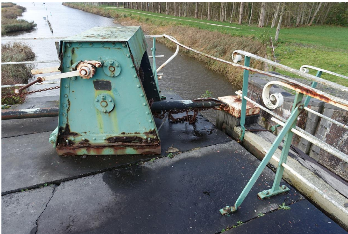
Figuur 145. Ouder, en iets zwaarder uitgevoerde kaapstander van de zuidelijke stormdeur.
