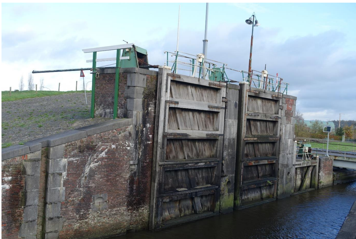
Figuur 95. Overzicht noordelijke sluiswand.
