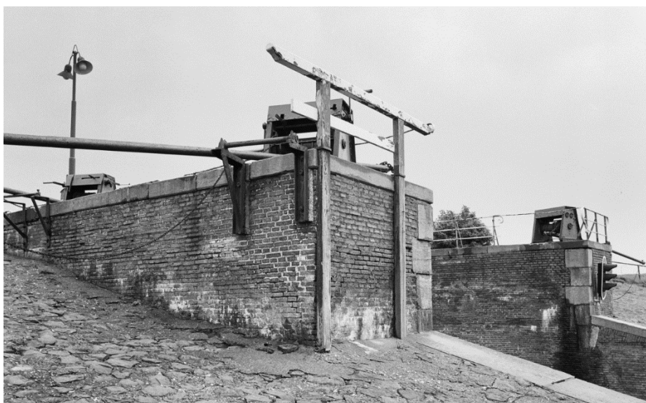
Figuur 75. Noordwesthoek van de sluis op 25 juni 1991. Bron: RCE, nr. 287.022, A.J. van der Wal.
