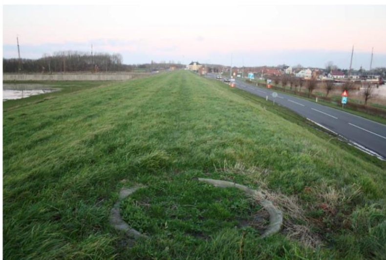
Figuur 159. Ring van de betonnen éénpersoon bunker op de kruin van de dijk.
