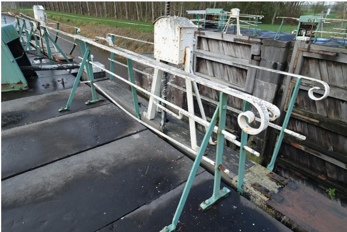
Figuur 135. Overzicht hekken langs de noordzijde van de zuidelijke frontmuur.
