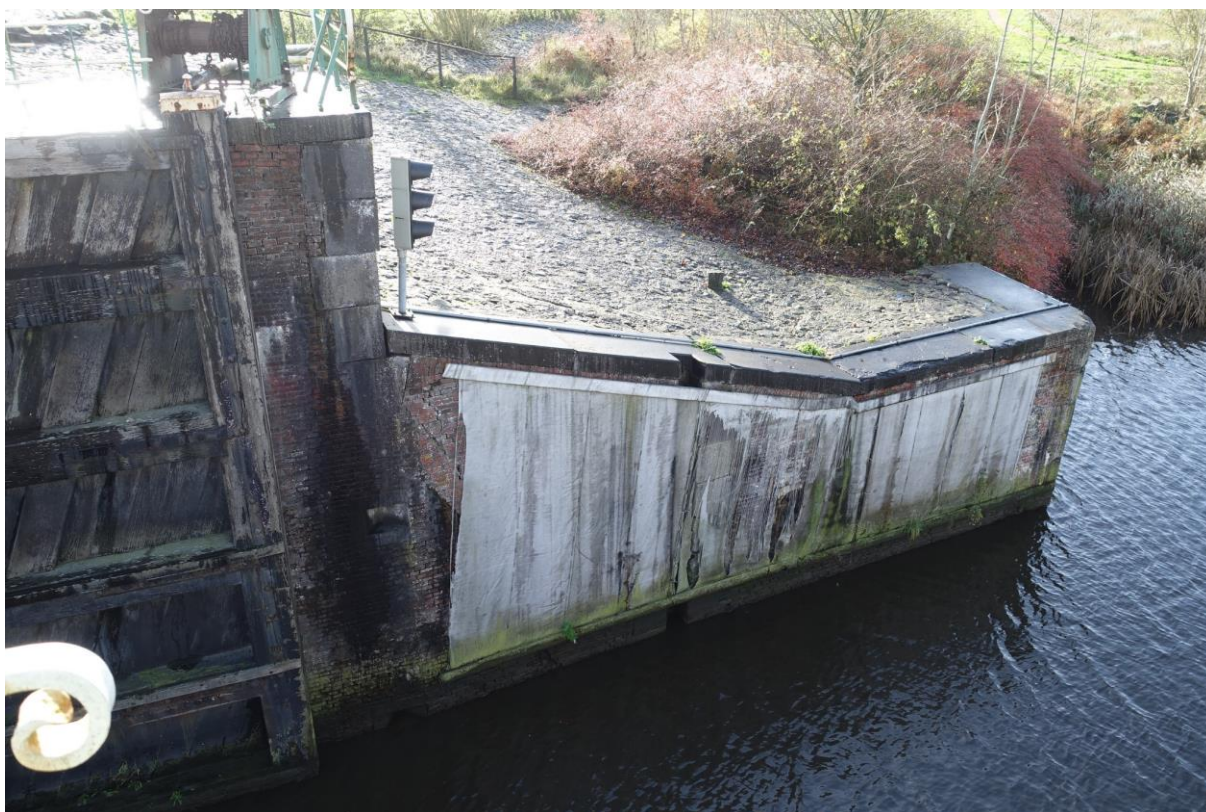
Figuur 107. Overzicht zuidwestelijke vleugelmuur.
