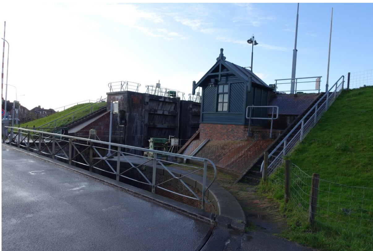
Figuur 147. Beeld van de recente terreinverhardingen rond de oostzijde van de sluis.
