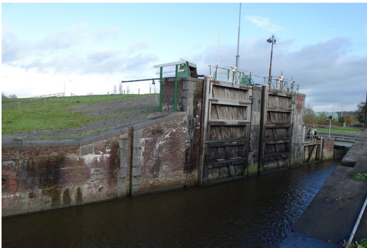
Figuur 88. Noordelijke sluiswand.
