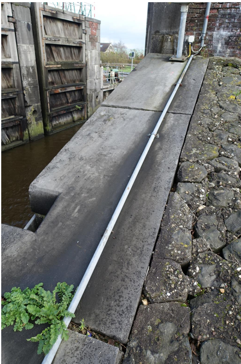
Figuur 109. Vernieuwde afdekkingen op het hellende deel van de zuidwestelijke vleugelmuur.
