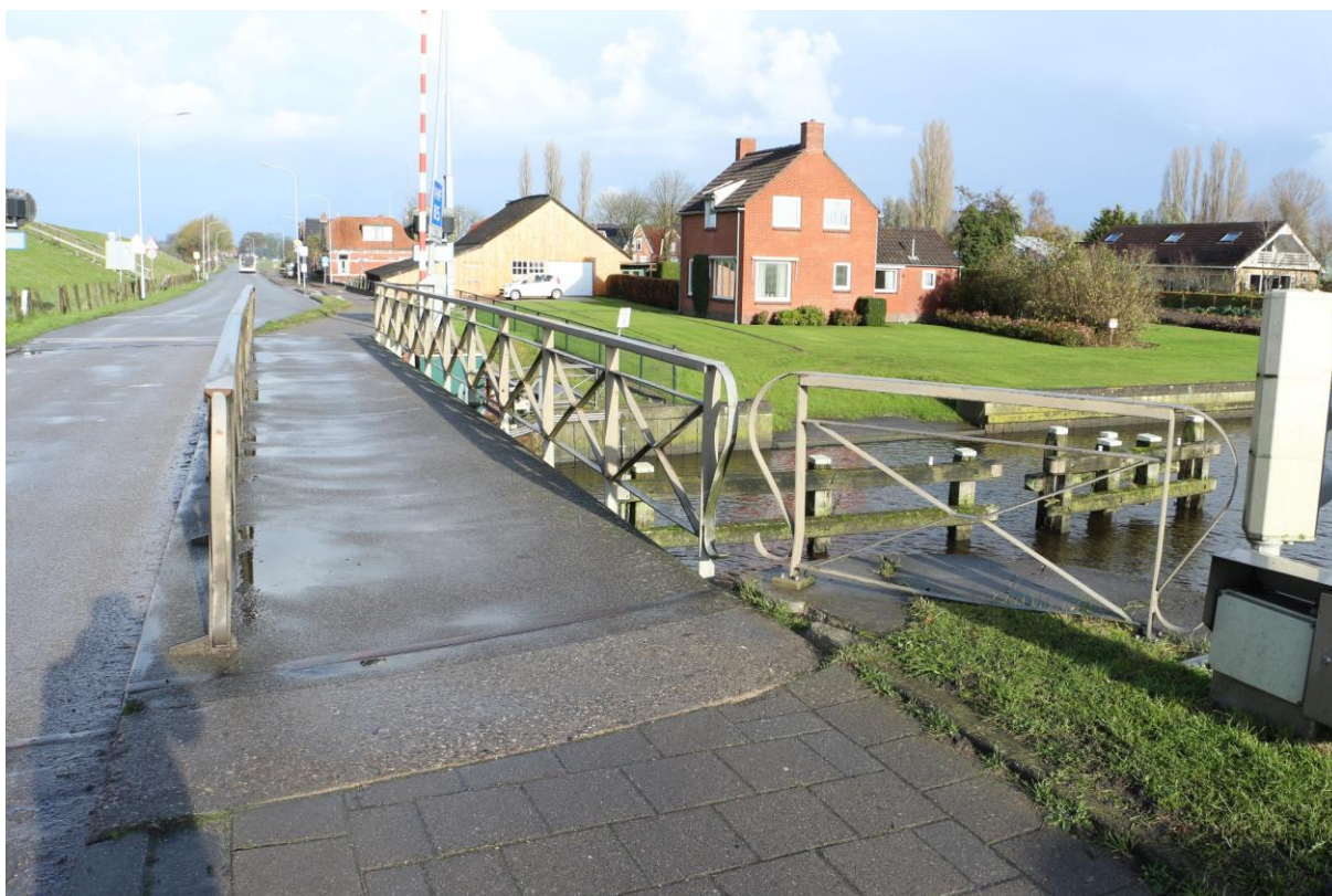
Figuur 82. Zicht over de Hunsingobrug in noordelijke richting. Het gebied ten noorden van de brug is veel minder dicht bebouwd.
