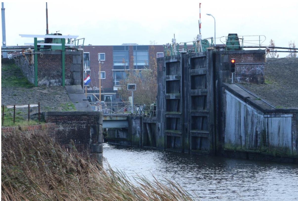
Figuur 96. Westzijde van de sluis.
