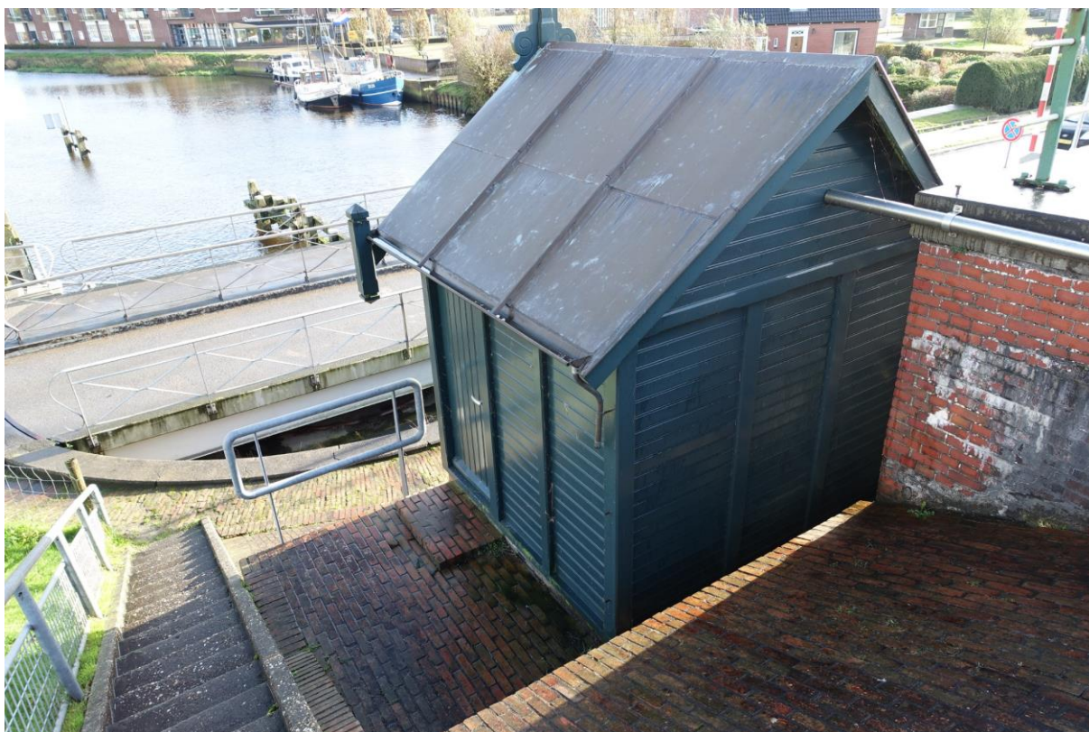
Figuur 119. Achterzijde van het sluiswachtershuisje en aansluiting van het talud op de noordelijke frontmuur.
