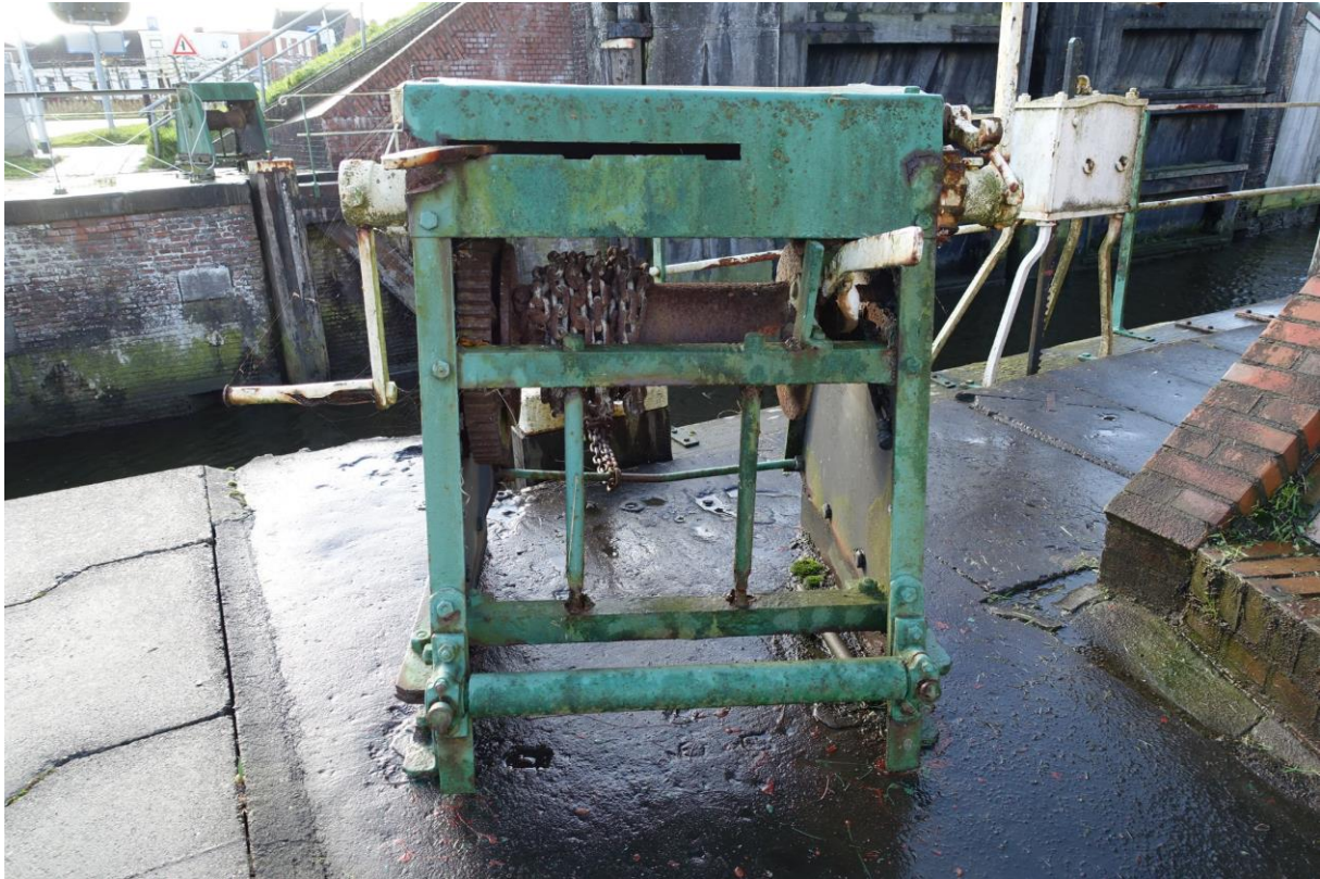
Figuur 138. Achteraanzicht van de kaapstander bij de noordelijke ebdeur.
