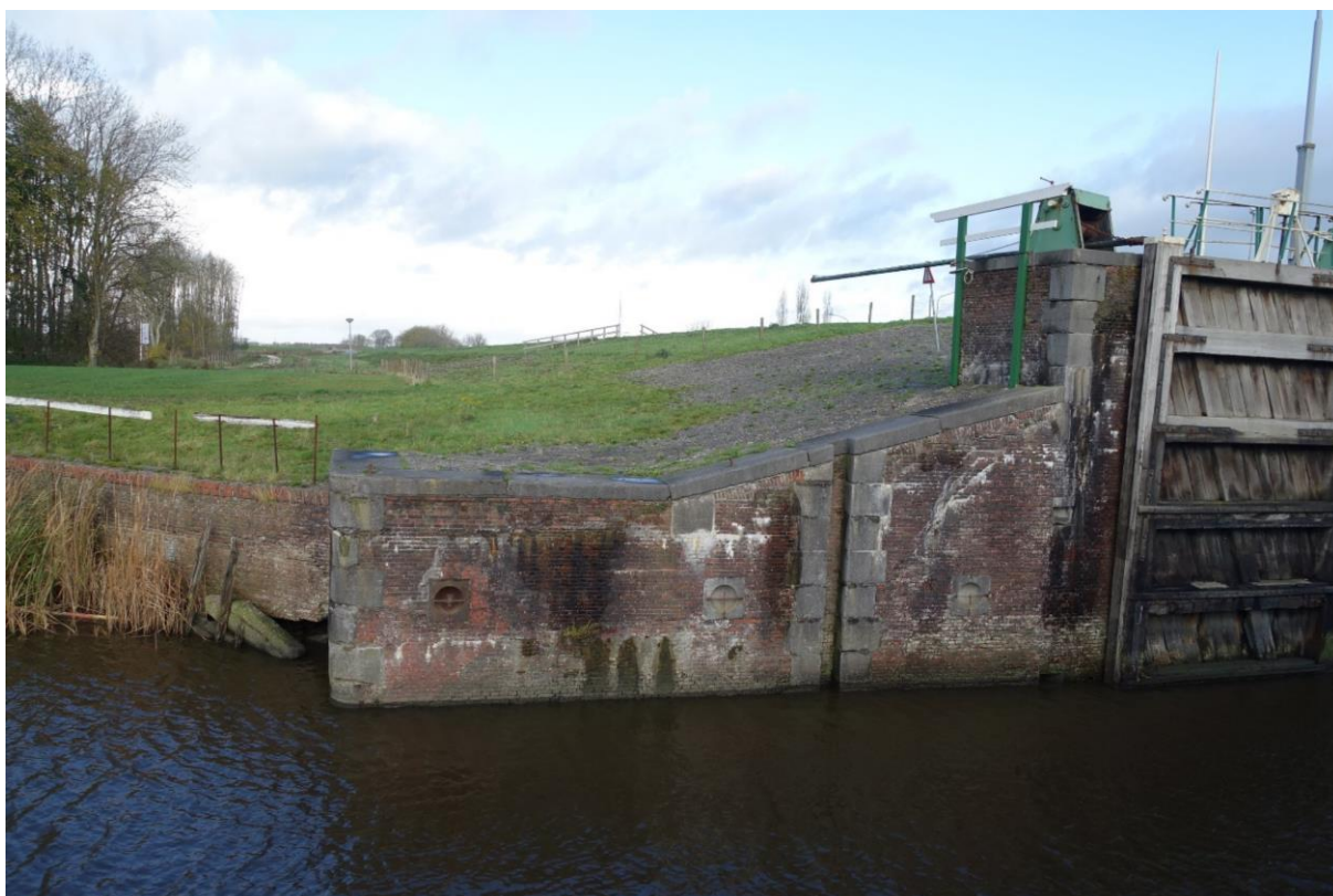
Figuur 89. Vleugelmuur aan de westzijde van de noordelijke sluiswand.
