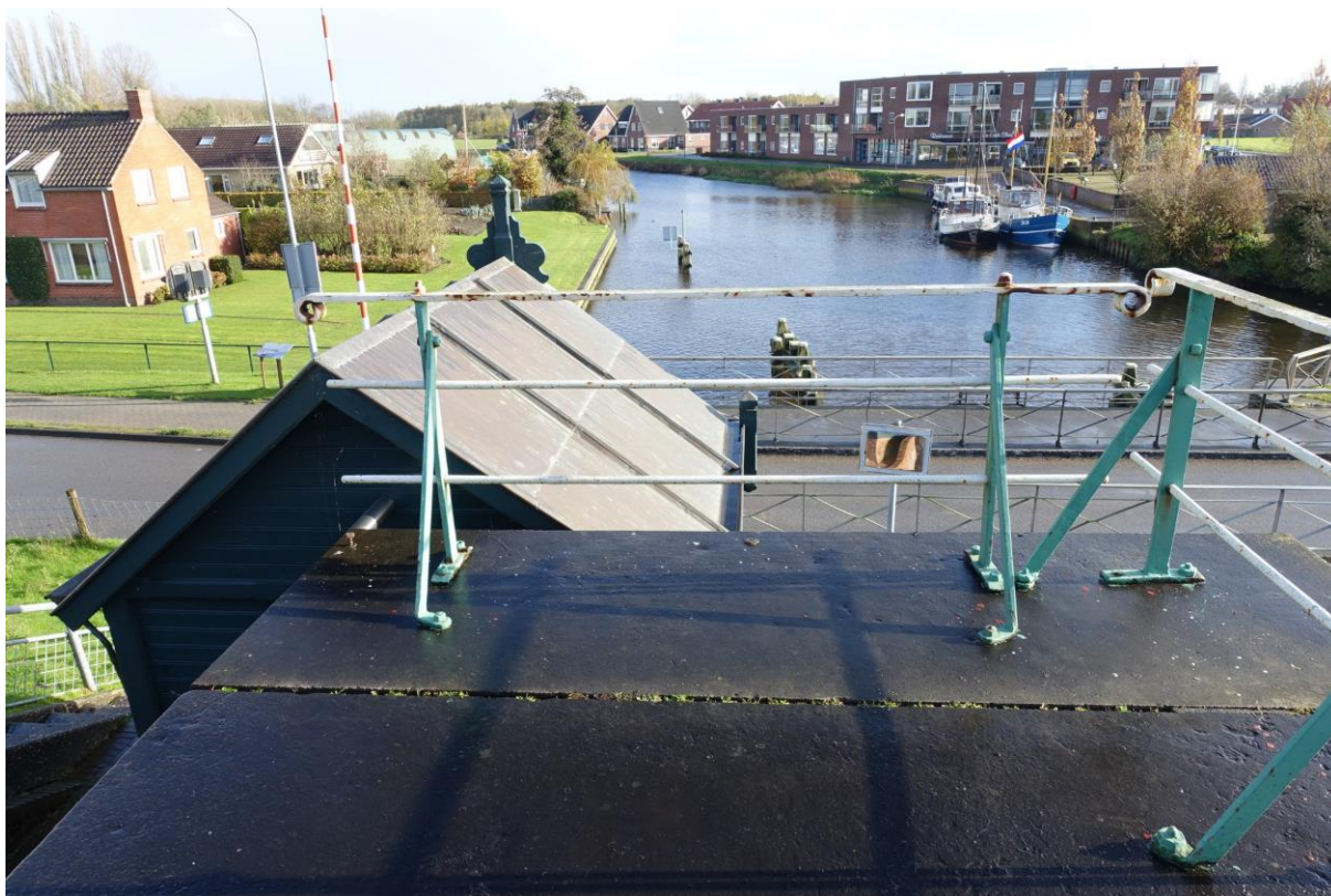
Figuur 130. Hek boven de oostzijde van de noordelijke frontmuur. Dit hek werd met boutverbindingen hersteld.
