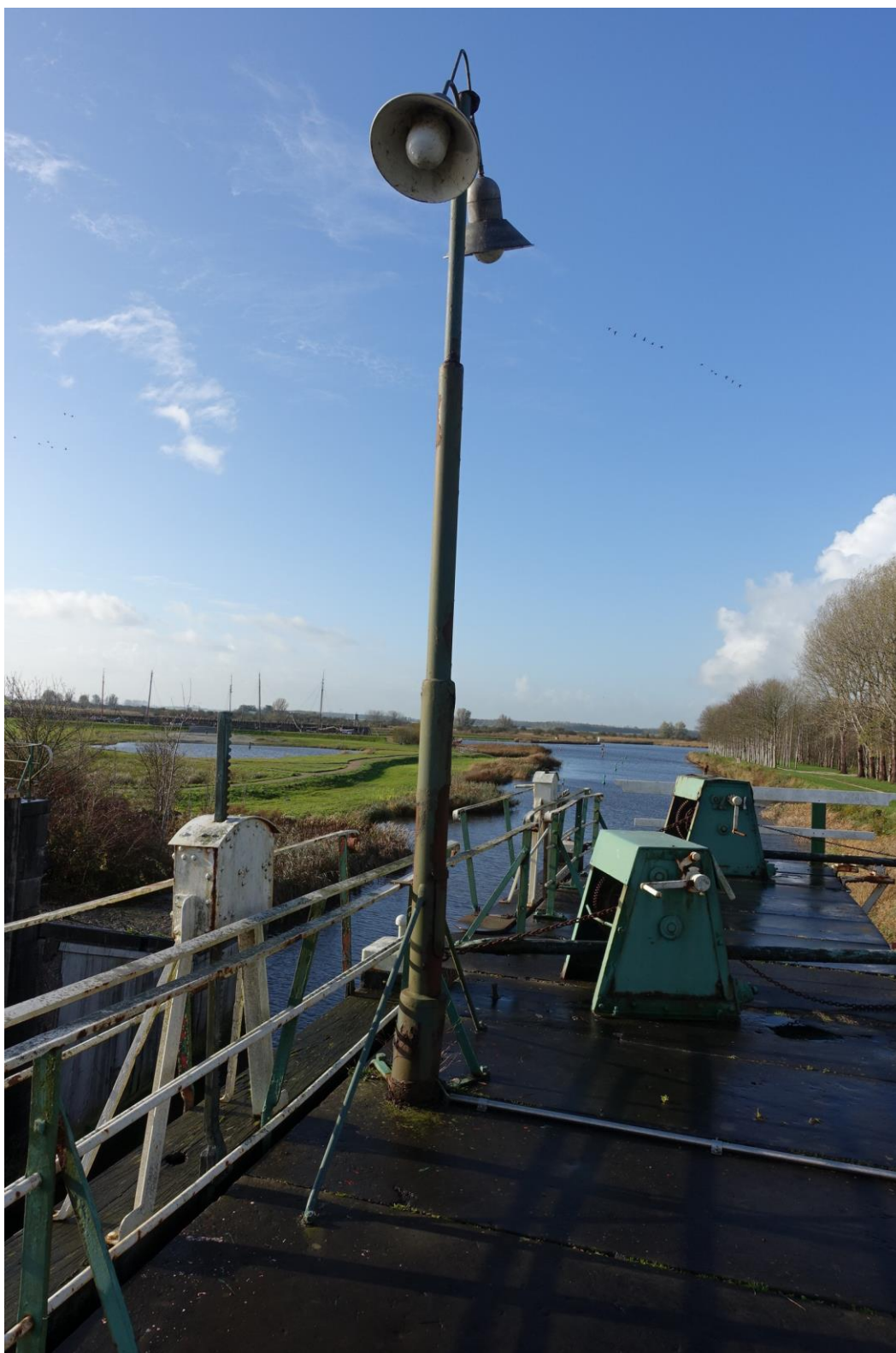
Figuur 136. Oudere lichtmast op de noordelijke frontmuur.
