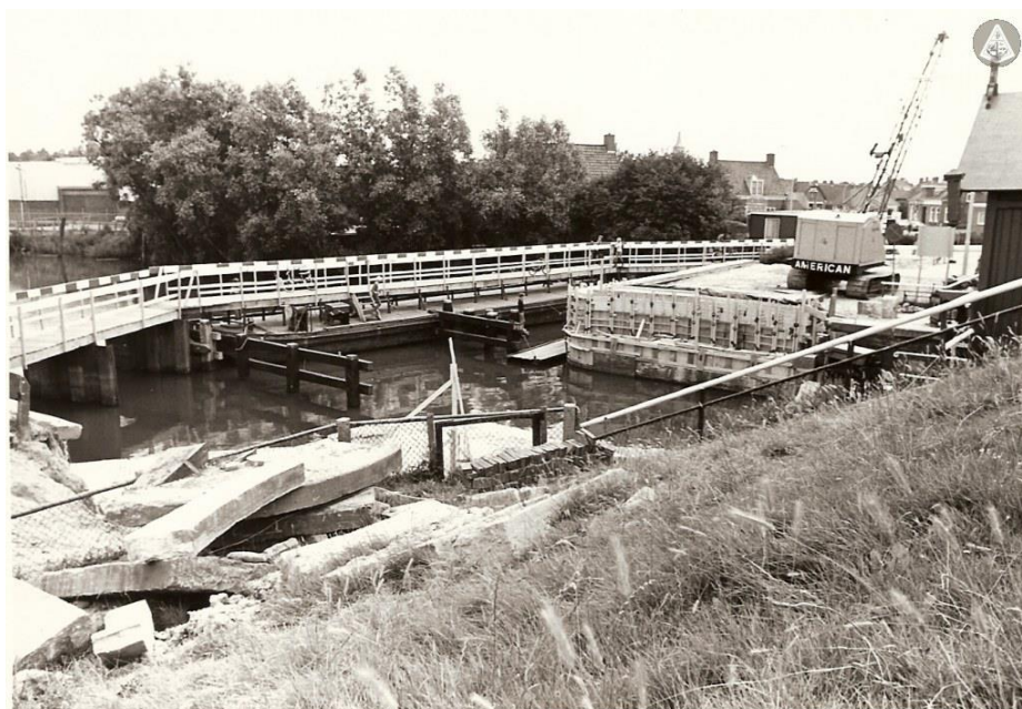
Figuur 67. Zicht op de werkzaamheden t.b.v. de vernieuwing van de brug over de Hunsingosluis op 30 juli 1981. Bron: Facebookpagina Oud Zoutkamp.
