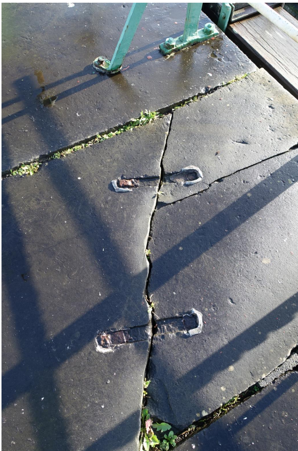
Figuur 99. Detail van herstellingen in de oorspronkelijke hardstenen dekplaten.
