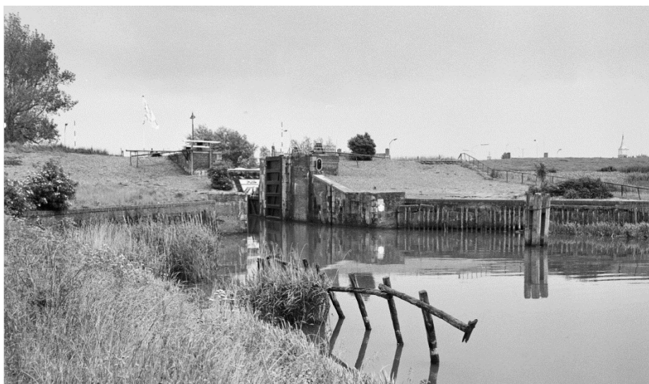
Figuur 76. Overzicht buitenzijde van de sluis op 25 juni 1991. Bron: RCE, nr. 287.023, A.J. van der Wal.
