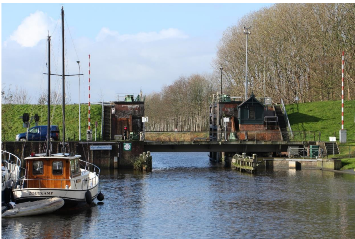
Figuur 90. Overzicht van de sluis uit het oosten.
