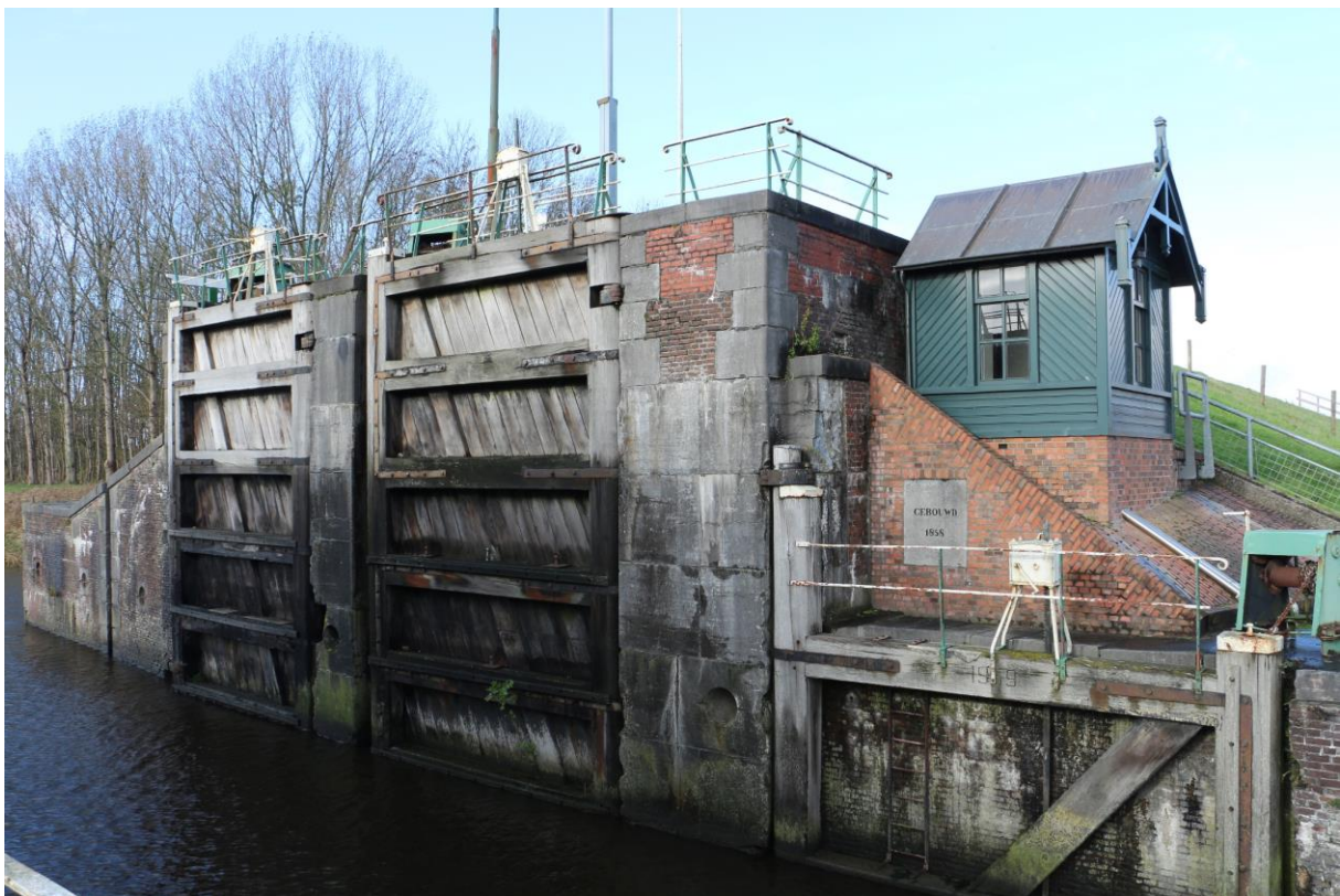
Figuur 128. Overzicht noordelijke sluisdeuren.
