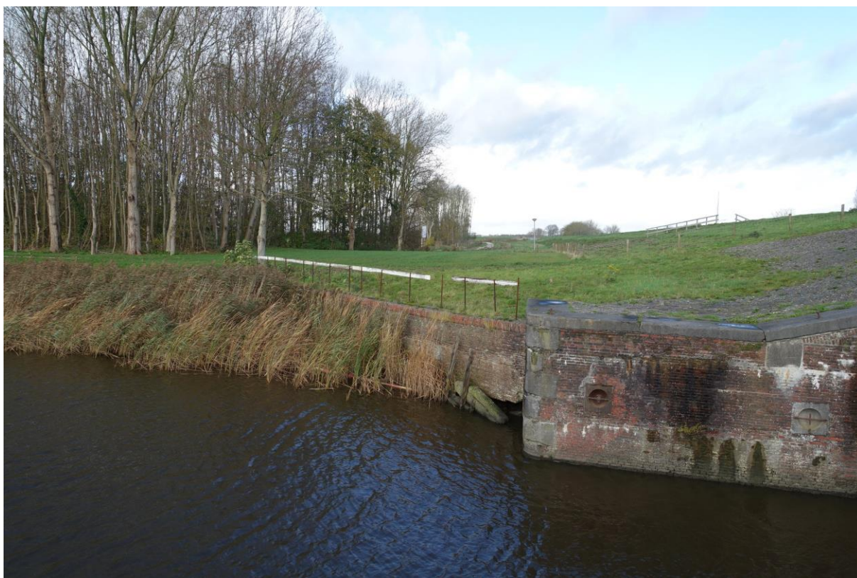
Figuur 153. Oudere (maar niet oorspronkelijke) kademuur, aansluitend op de noordwestelijke vleugelmuur.
