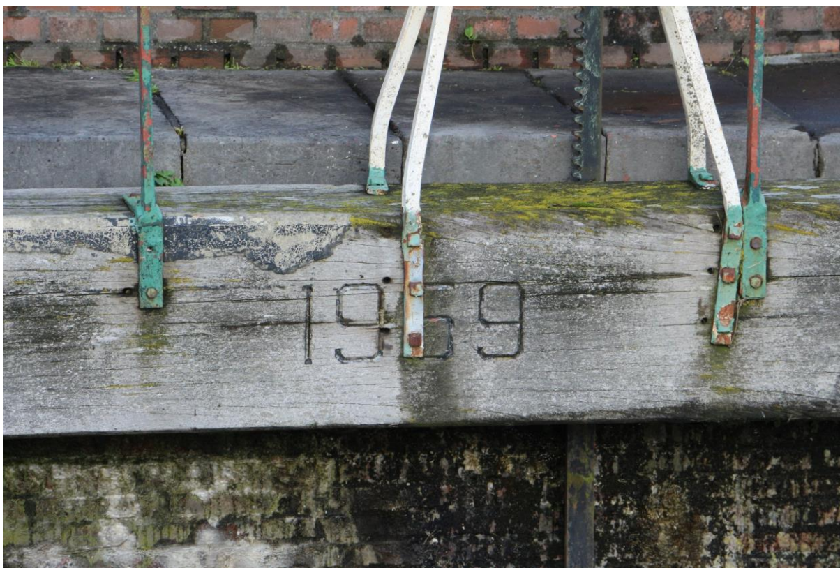
Figuur 129. Detail bovenregel van de noordelijke sluisdeur met de datering '1959'.
