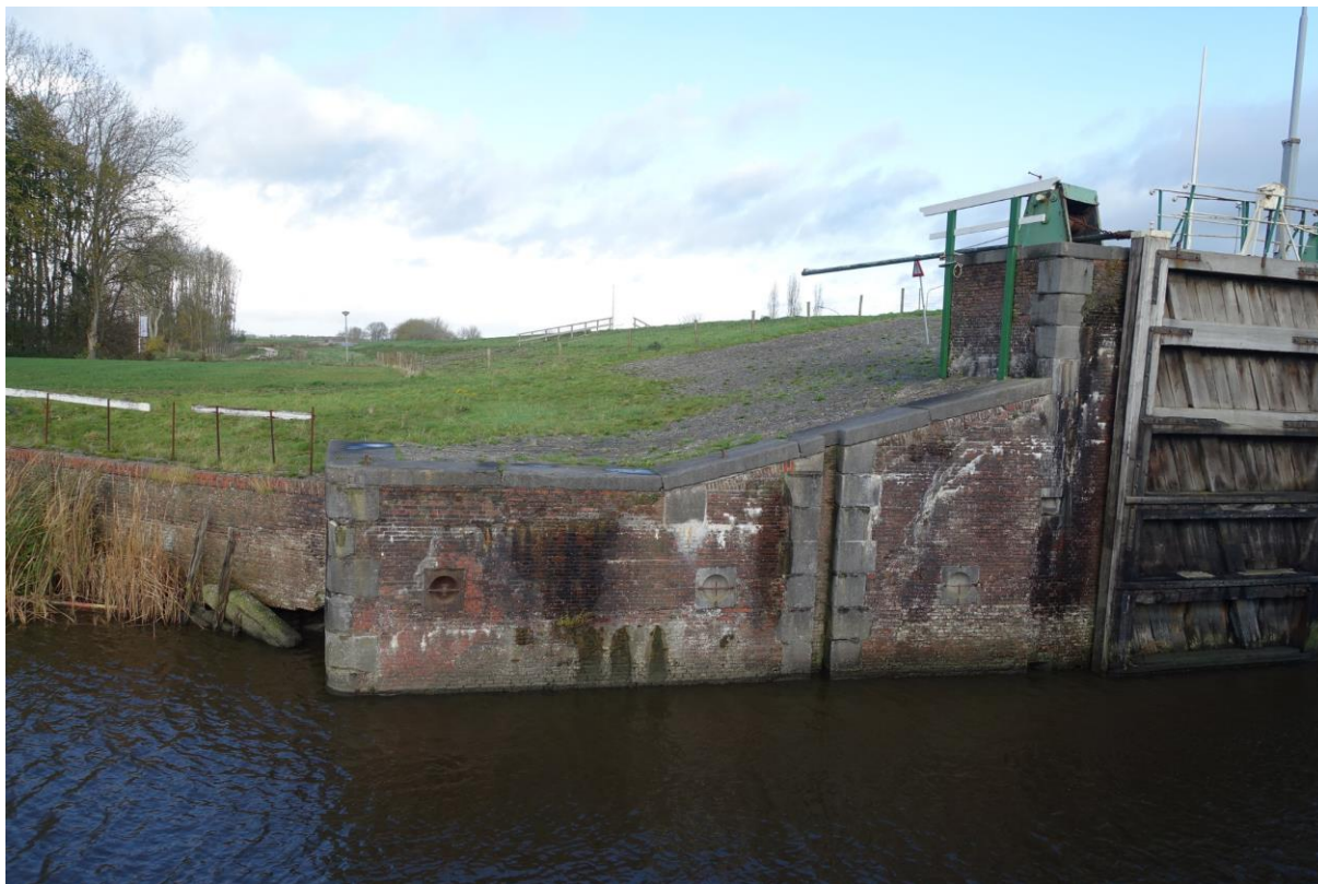
Figuur 105. Overzicht noordwestelijke vleugelmuur.
