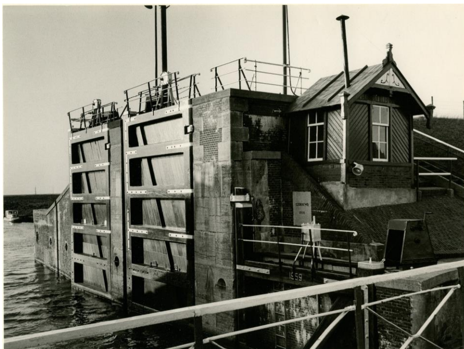
Figuur 65. Overzicht van de noordzijde van de sluis in 1976. Bron: GA, nr. 818_18734.
