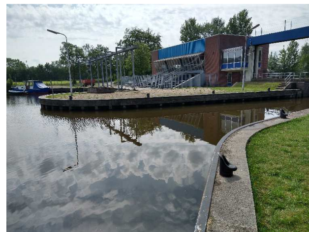
Foto 66: Situering H.D. Louwes gemaal
