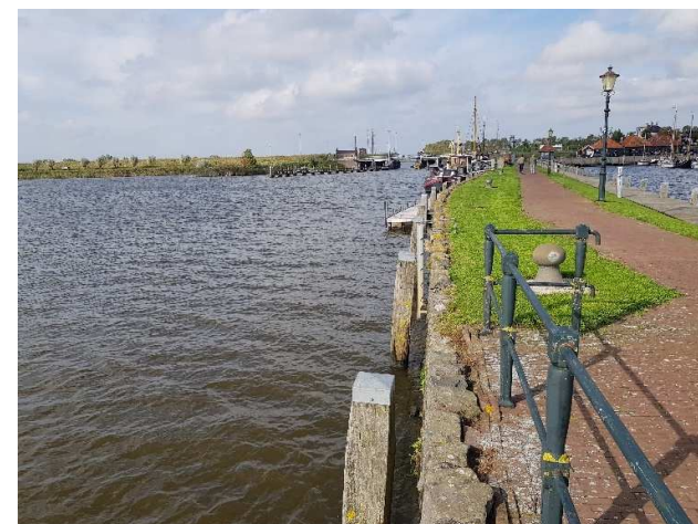
Foto 12: Situering aanmeervoorzieningen Reitdiep haven
