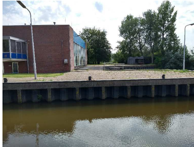
Foto 68: Situering H.D. Louwes gemaal
