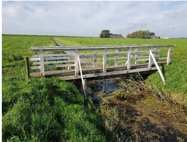
Foto 74: Situering bruggetje Panserpad
