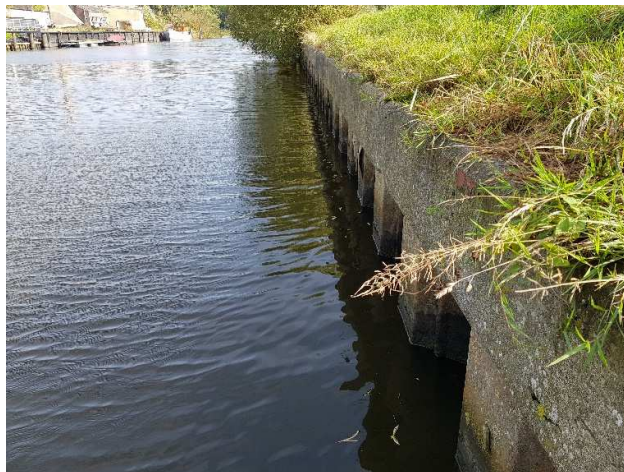
Foto 62: 6 Situering beschoeiing Hunsingokanaal (metalen damwand beschoeiing)
