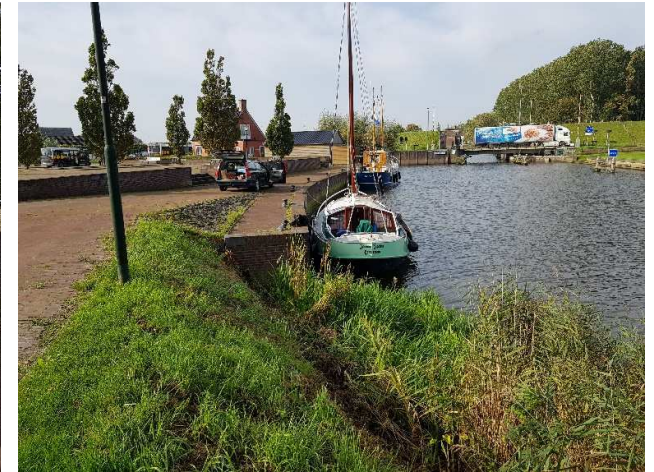
Foto 51: Situering uit te breiden aanlegplaatsen Hunsingokanaal
