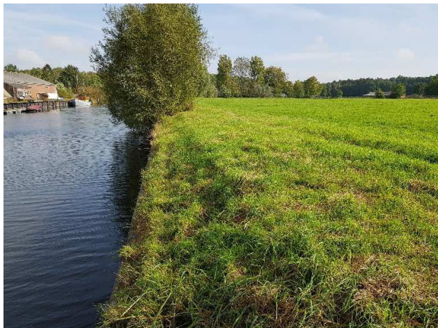
Foto 61: Situering beschoeiing Hunsingokanaal (metalen damwand beschoeiing)
