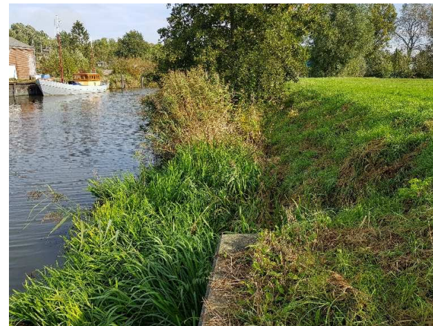
Foto 63: Situering beschoeiing Hunsingokanaal (overgang van metalen damwand beschoeiing naar geen beschoeiing)
