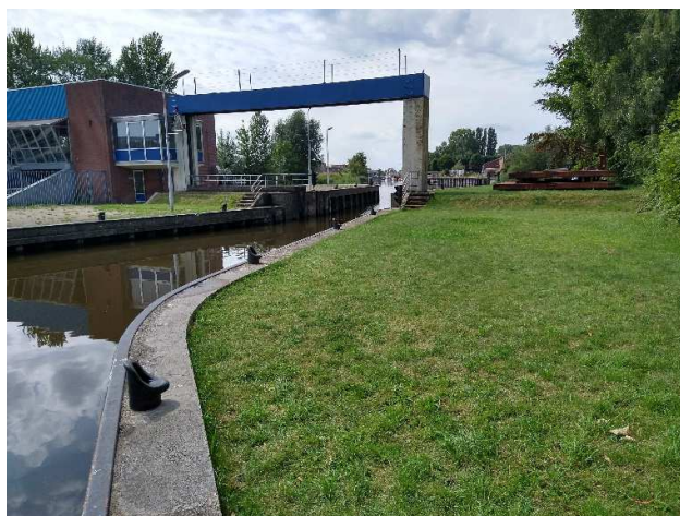
Foto 65: Situering H.D. Louwes gemaal
