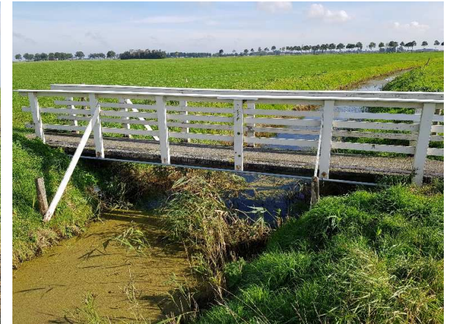
Foto 75: Situering bruggetje Panserpad
