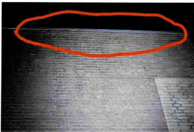
Foto 3 | Gecombineerd zomer- en paarverblijf. De cirkel markeert de zone waarin open stootvoeg toegang bieden tot het verblijf in de achterliggende spouw.
