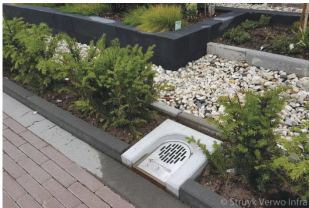
Figuur 4– Uitstroomtegelt Well-o-Edge (Bron: Struik Verwo Infra)
