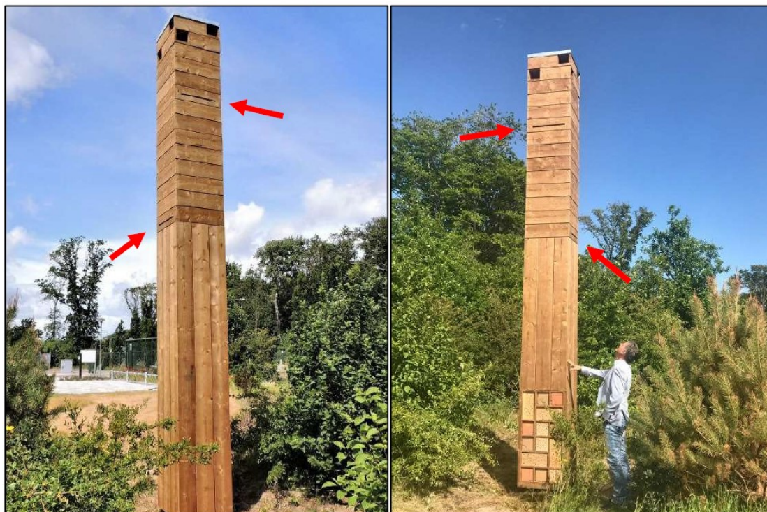
Figuur 3. Als permanenten mitigatie wordt een faunatoren (type EColumn) geplaatst binnen het projectgebied. De rode pijlen geven de invliegopeningen van de vleermuiskasten weer. In de EColumn worden de volgende voorzieningen aangebracht:
