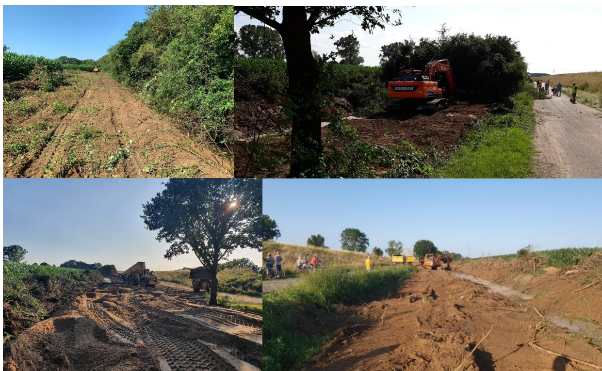
Figuur 11 Foto's impressie werkzaamheden aanleg stabiliteitsberm
