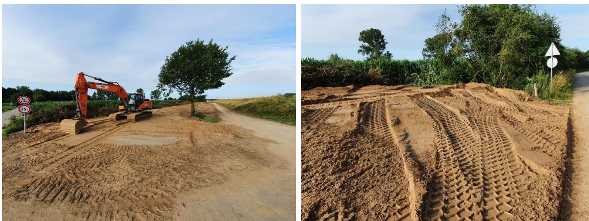
Figuur 12: Foto's impressie gerealiseerde stabiliteitsberm
