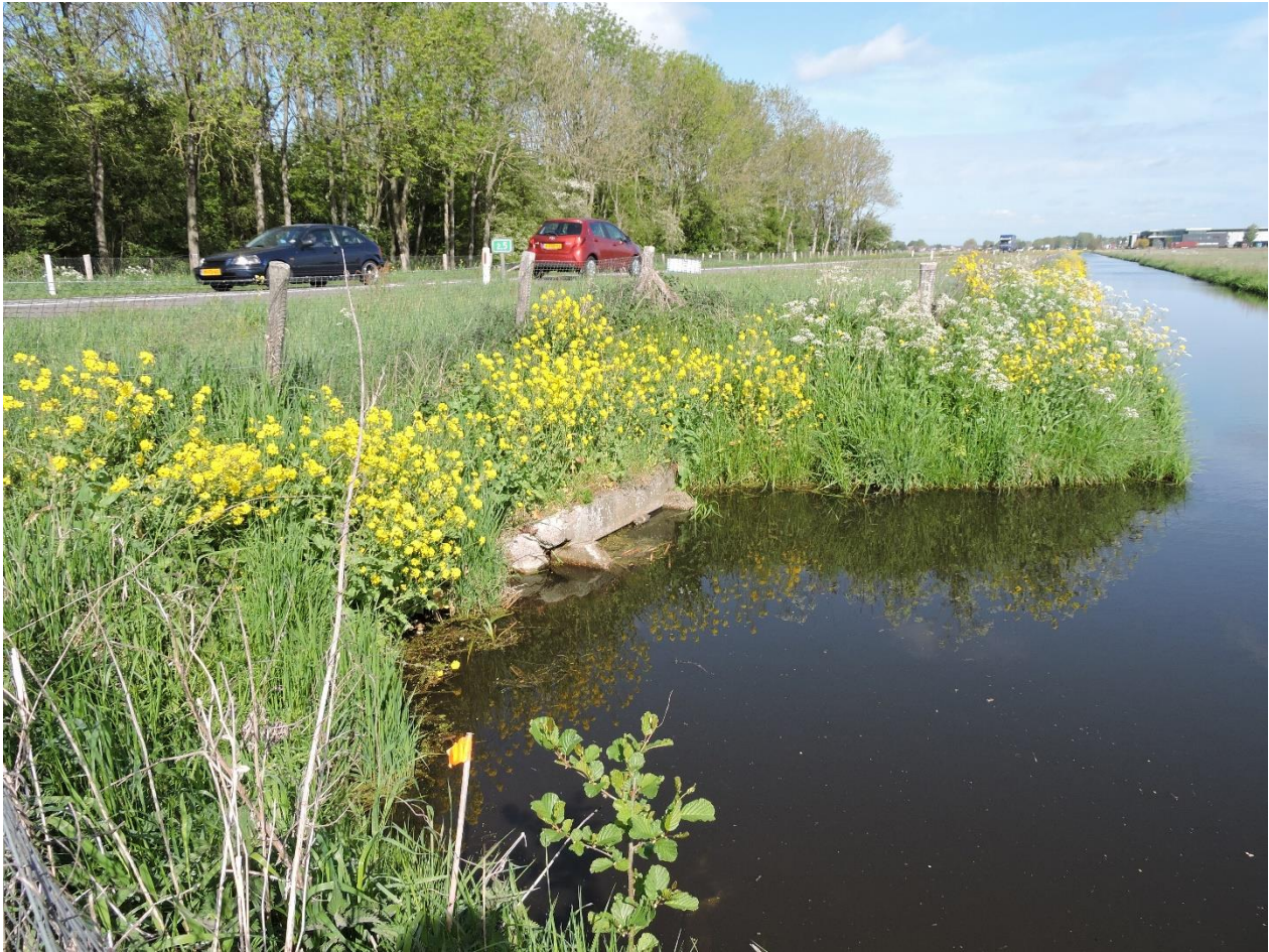
Figuur 6-1 Ottertunnel in de omgeving van het onderzoeksgebied. Deze doorkruist de N759 ter hoogte de Roebollige Kreek.
