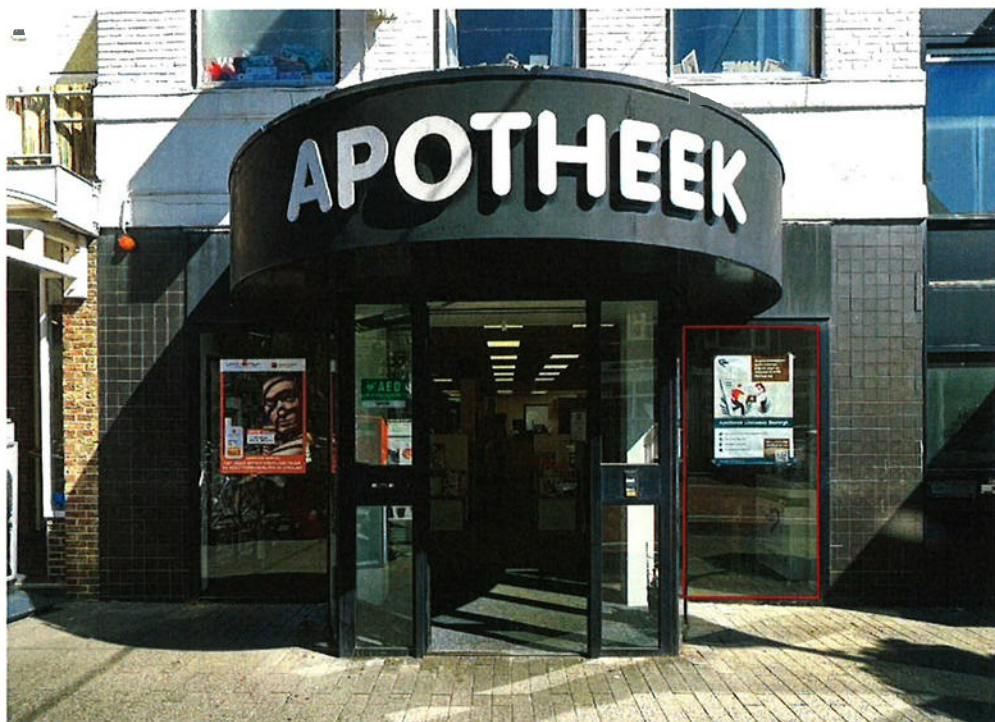
Foto 2: Huidige situatie met rood omkadert raam (rechts naast ingang) waar de medicijnautomaat geplaatst zal worden. Afmetingen raam: 104 cm breed, 234 cm hoog.
