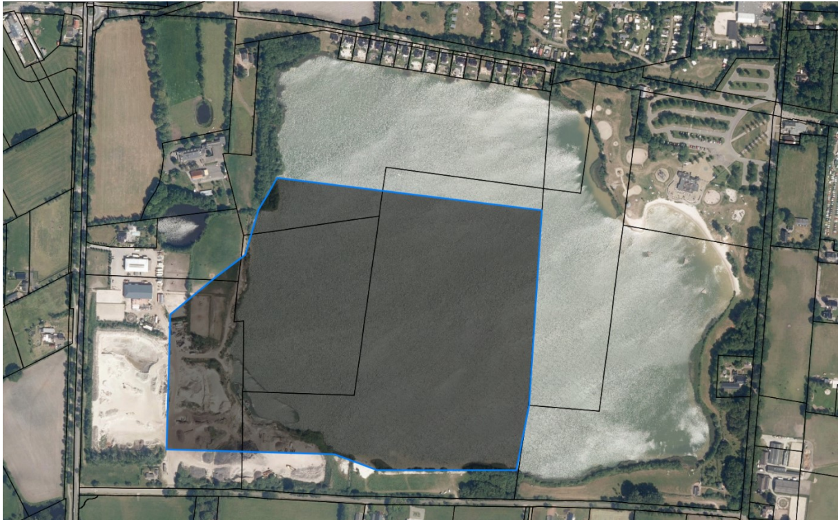
Figuur 1: Luchtfoto situering ontgronding plangebied (bron: Esri Nederland)
