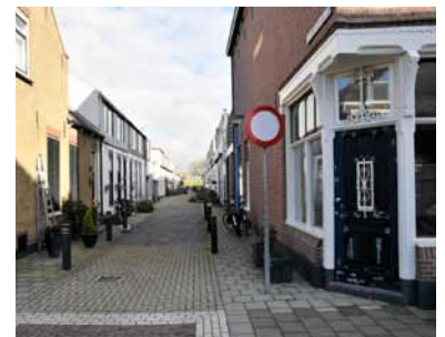
Ouder pand met rijke detaillering ter plaatse van de entree
