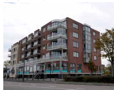
Gevels bestaan voornamelijk uit baksteen in combinatie met glazen puien
