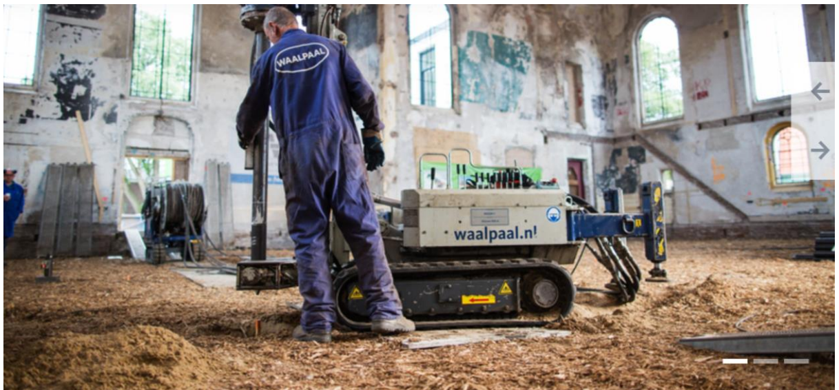
Afbeelding 5 Impressie werkzaamheden. Bron: Waalpaal. 13
