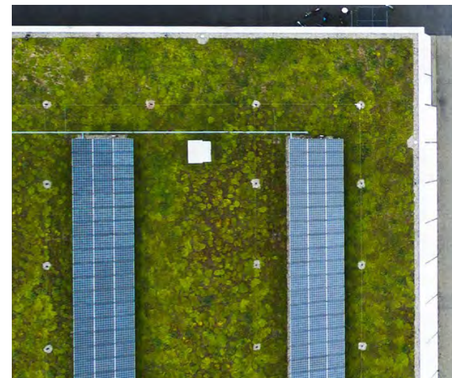
[Afbeelding: zonnepanelen op groene daken]
