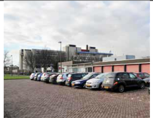
Relatief grote bouwmassa's staan vrij op de kavel en vormen openbare ruimte
