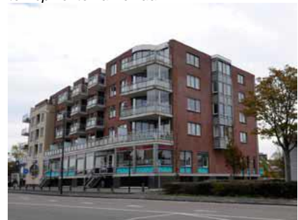
Gevels bestaan voornamelijk uit baksteen in combinatie met glazen puien
