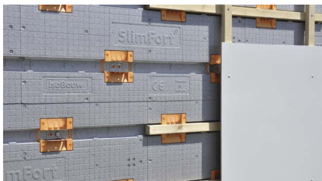
Afwerking met vezelcementplaten
