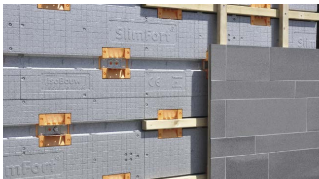
Afwerking met tegels
