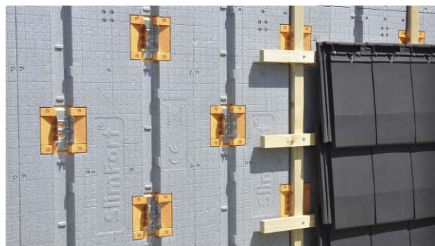
Afwerking met pannen
