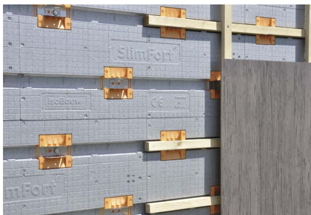
Afwerking met geperste minerale wol platen
