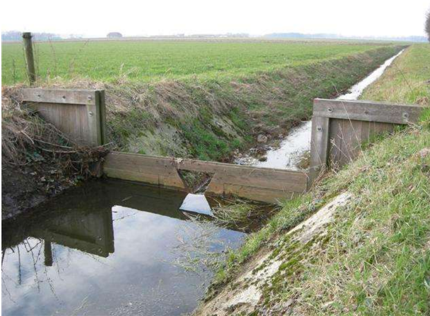
Figuur 6.1: Voorbeeld van een knijpstuw
