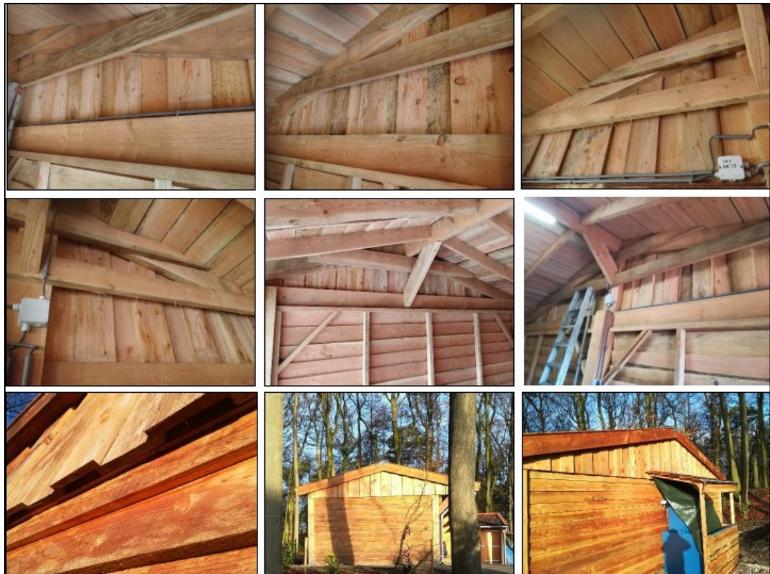
Figuur 3. Een impressie van de gecreëerde duurzame verblijfplaatsen voor vlemuizen achter gevelbetimmering van de (nieuwe) kapschuur. Bovenste en middelste rij : binnenzijde van de permanente verblijfplaatsen in de kapschuur. Onderste rij : toegangen aan de onderzijde van de betimmering (links) en een overzicht van de buitenzijde (midden en rechts).
