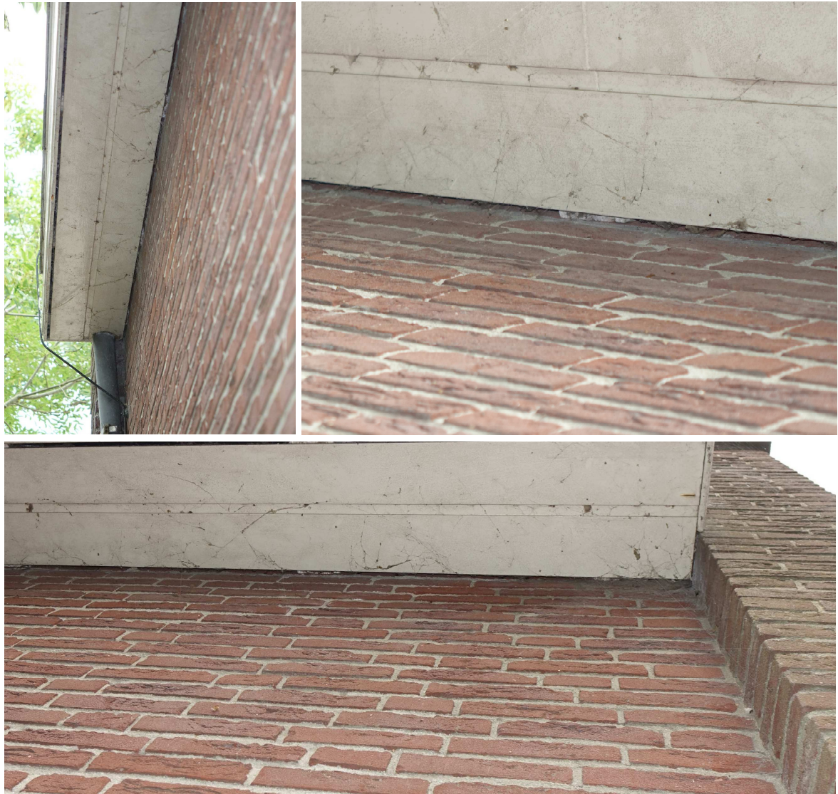
Figuur 4. Oud vuil en spinrag langs de dakrand
