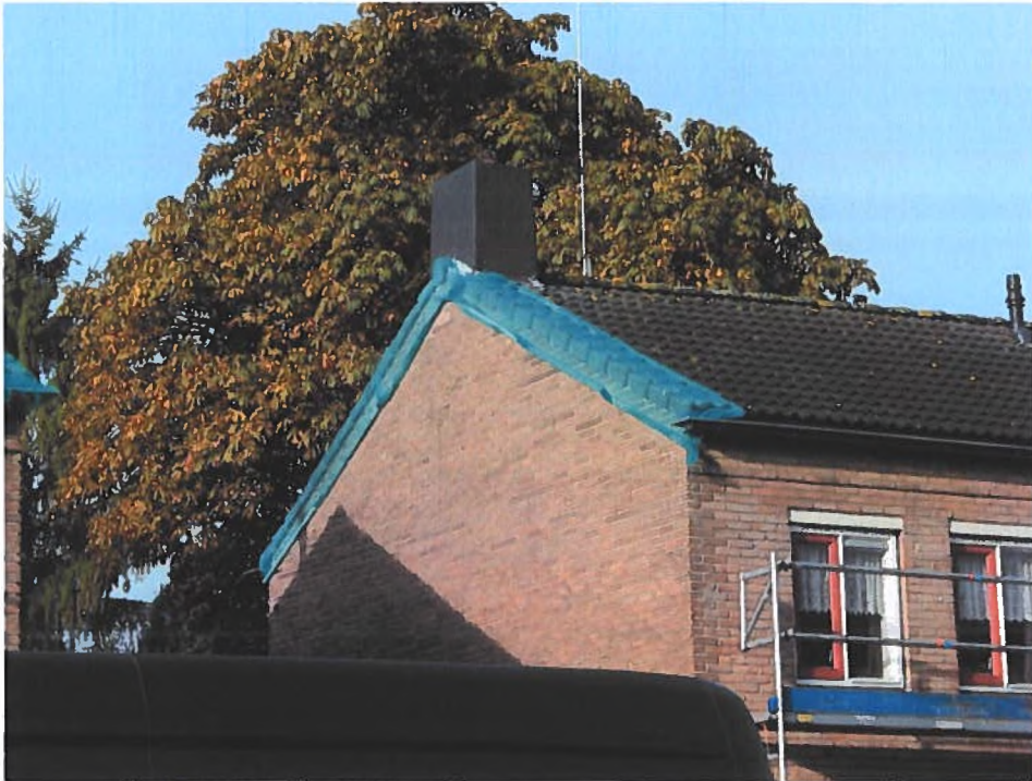
A. Netten worden over de gehele lengte van het dak gespannen, over de delen waar de vleermuisverblijfplaatsen zich bevinden.
