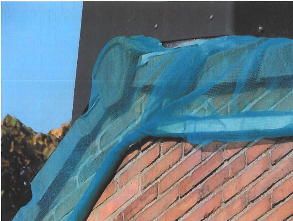
Detailfoto's met openingen waar vleermuizen langs kunnen kruipen en de verblijfplaats kunnen verlaten, maar er niet terug in kunnen.
