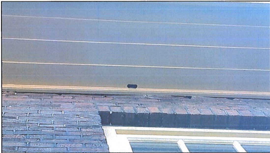
C. Voorbeeld van de permanente vleermuisvoorzieningen, gaten van 20mm x 50mm in de gootbak.
