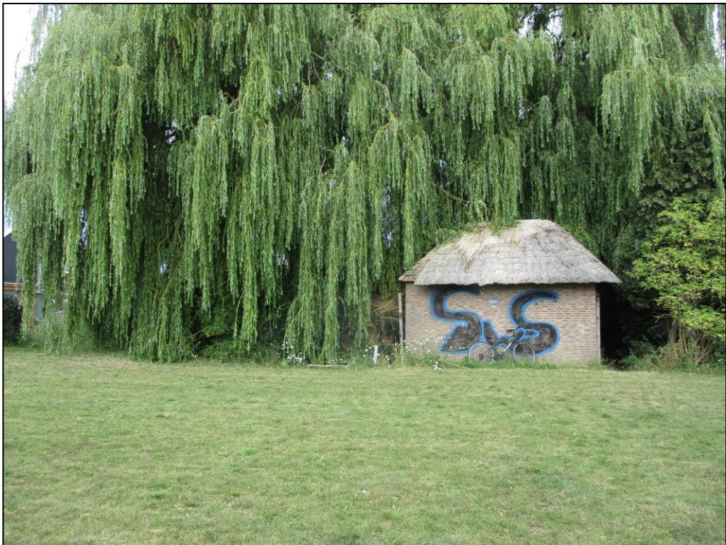
Figuur 2 Het elektriciteitshuis en de twee treurwilgen.
