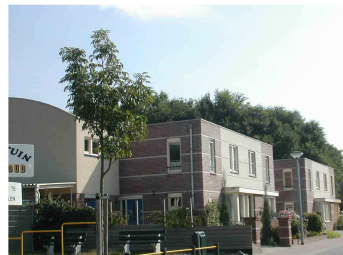
Afwijkende eigentijdse architectonische woningen in het Zonnewoud.
