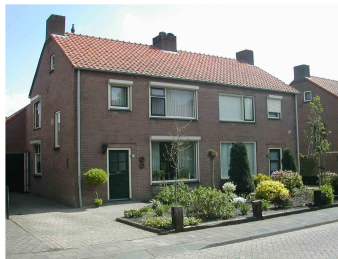
Zijgevels voorzien van meerdere ramen is opvallend.
