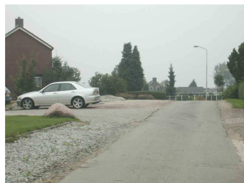
Duidelijk zichtbaar hoogteverschil bij het bebouwingslint van Woerd.
