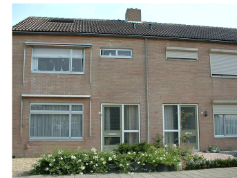
Naast elkaar gelegen woningen met een gespiegelde gevelindeling zorgen voor een sterke ritmiek.
