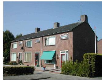
Prefab-elementen boven ramen en deuren.
