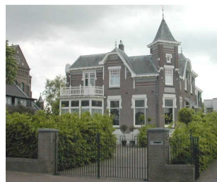
Karakteristieke historische bebouwing.
