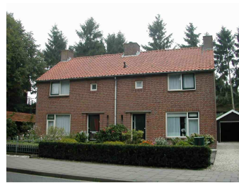
Sobere gevelindeling met details rond ramen en deuren.
