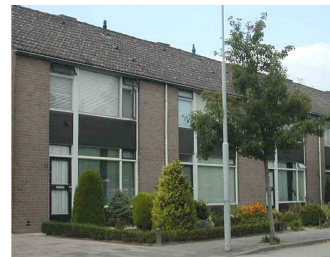
Wederopbouwarchitectuur met prefab gevelpui.
