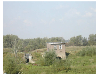
Bebouwing in uiterwaarden is beperkt, waaronder dit kleine gemaal.
