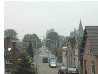
Gelsoten gevelwanden en Zichtbaar aflopend hoogteverschil bij de Waalbandijk
