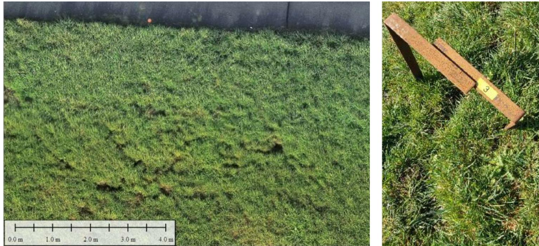
Figuur 2.5 Scheuren in de dijk
