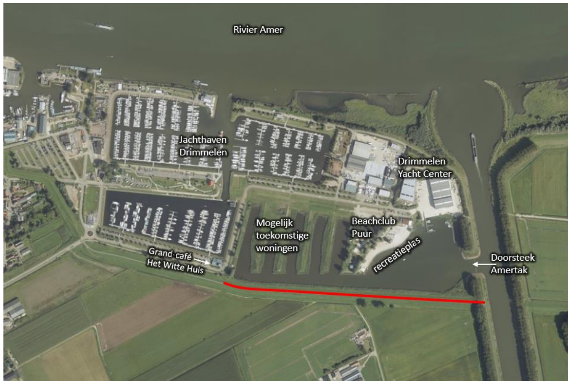
Figuur 2.2 Overzicht met huidige functies in het gebied en in rood het te versterken dijktraject.
