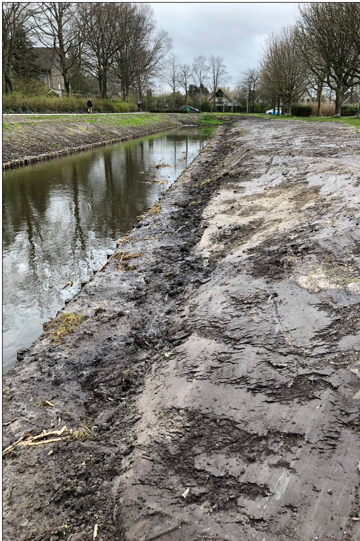
Nieuwe beschoeiing met plasberm in Wieringerwerf
