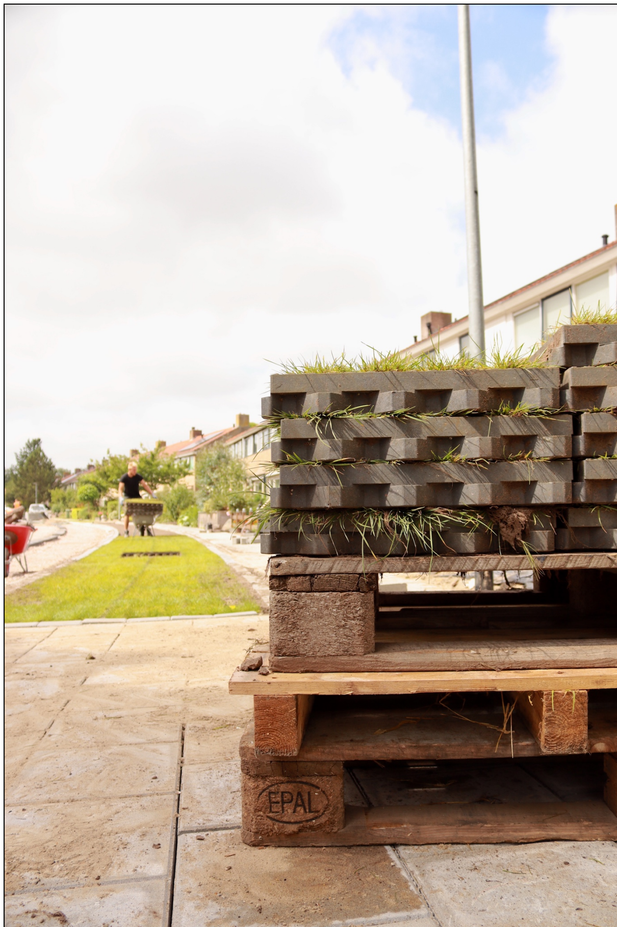
Aanleg groene parkeerplaats in Wieringerwerf
