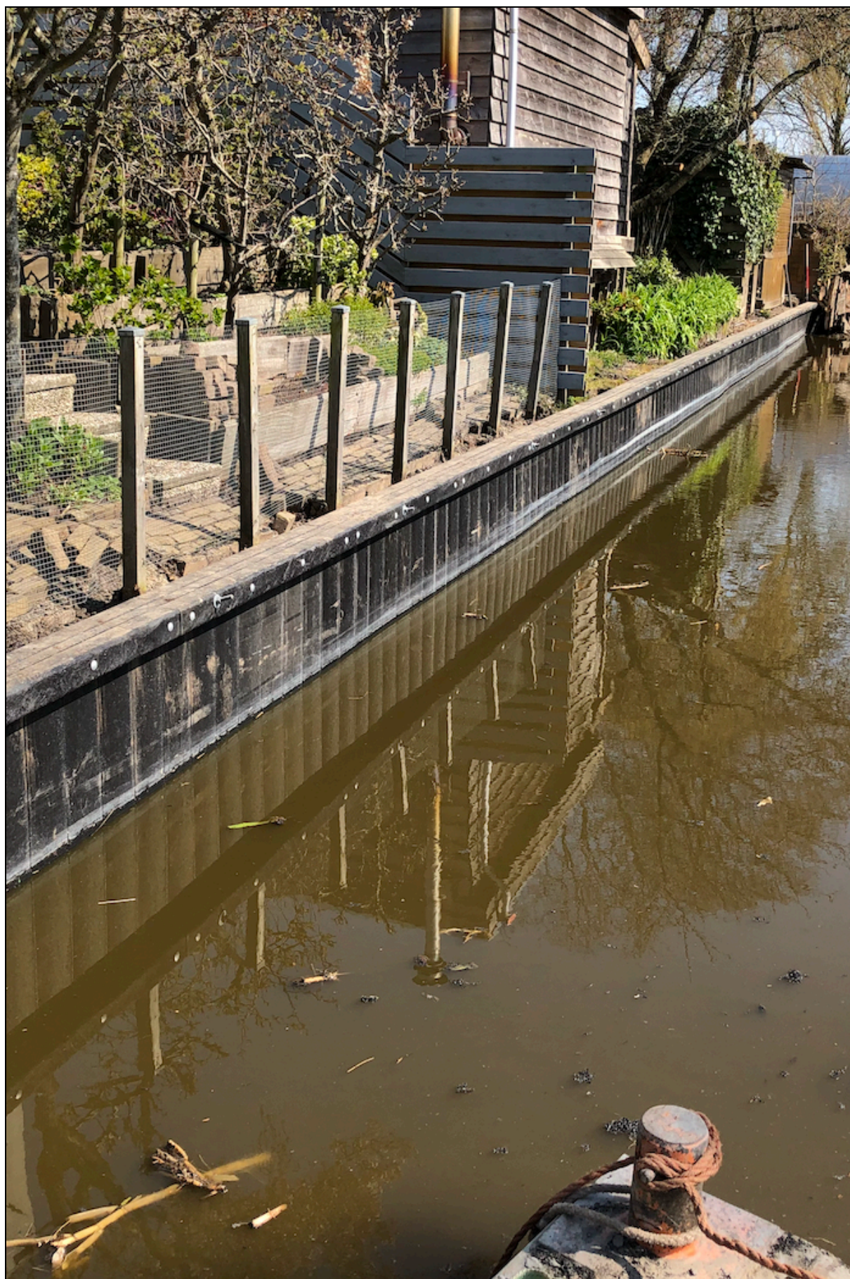
Nieuwe damwand van kunststof in Wieringerwerf
