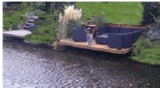
Het ontwerp heeft betrekking op een dakwand bescherming talud en een trapje.
