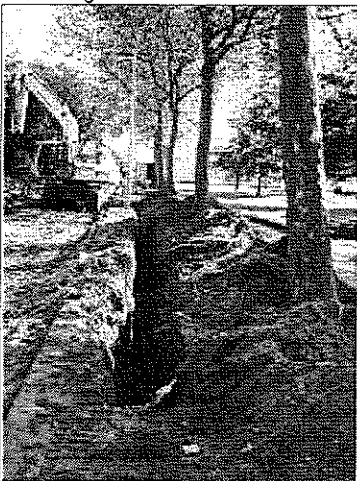
Graafwerkzaamheden binnen de kroonprojectie kunnen grote schade toebrengen aan de bomen
